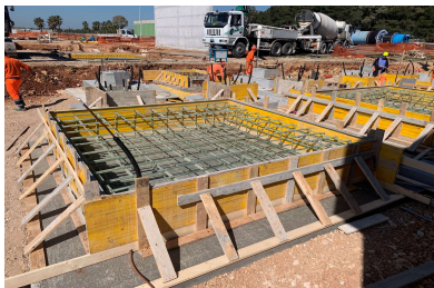
Gabbie di fondazione armate con barre Glasspre®
