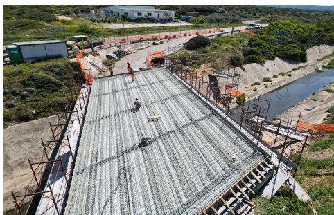
Ponte armato in GFRP: il primo realizzato in Europa con tecnologia ibrida acciaio-vetroresina. Sireg ha prodotto e fornito le armature Glasspre®.
