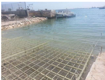
Armatura in vetroresina in ambiente marino.
