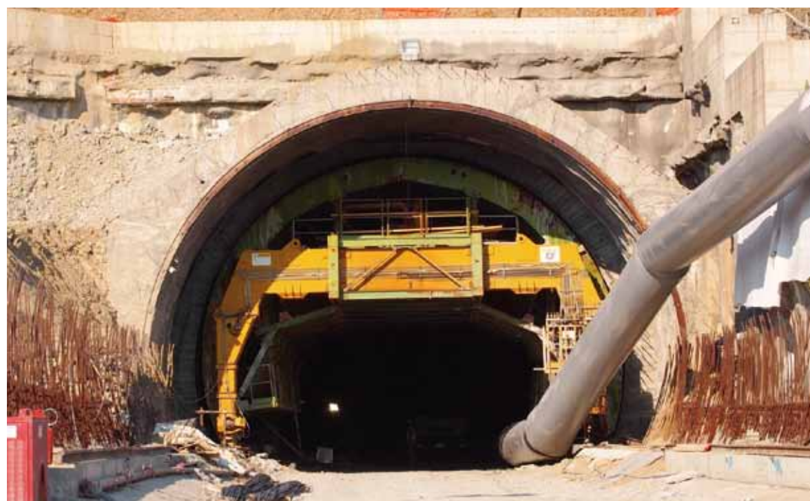
Introduzione della centina di una galleria della SS106 Jonica
