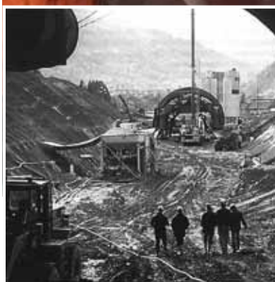
Scavo di tunnel di grande sezione
