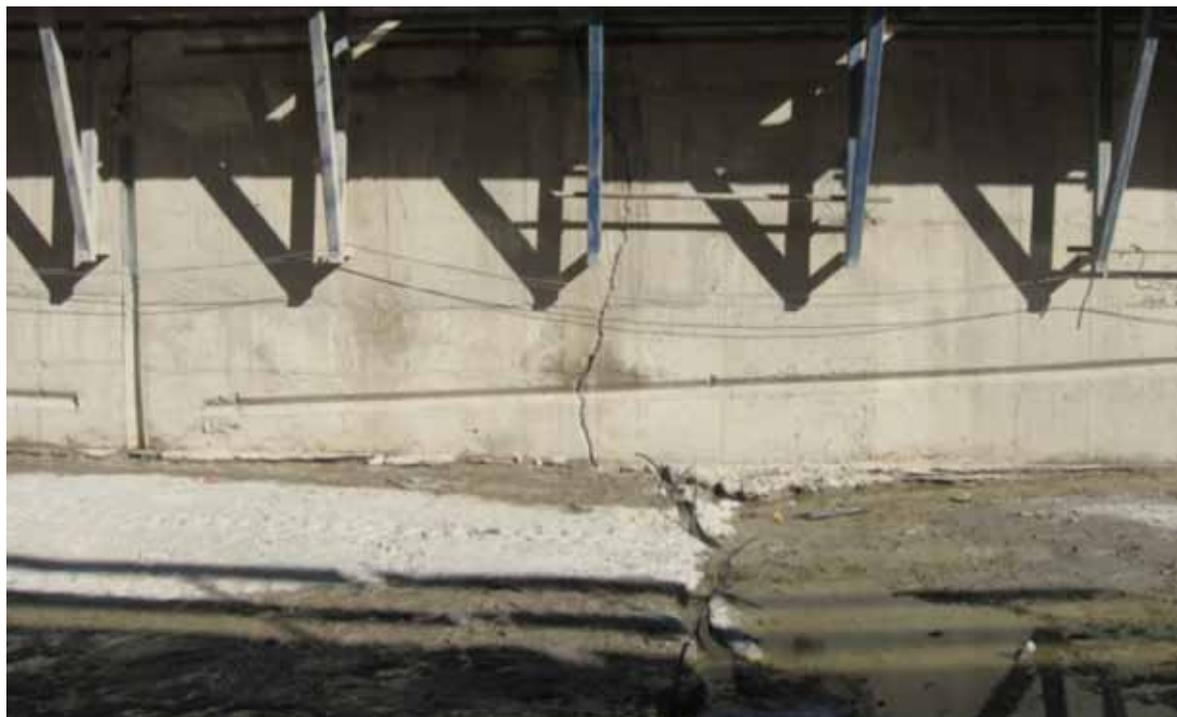
**Figura 1.** La situazione “estrema” di un calcestruzzo massivo, gravemente lesionato a seguito di uno sviluppo termico “incontrollato”.
