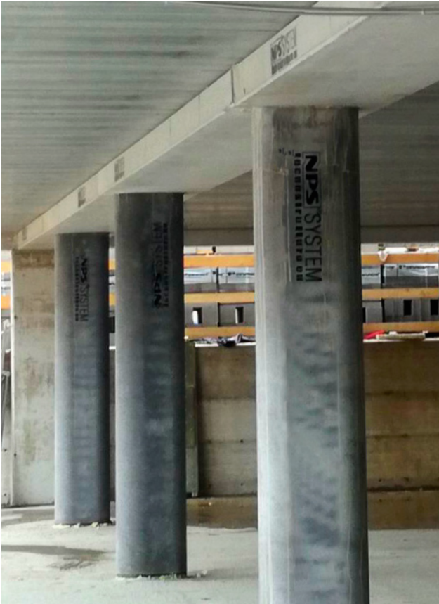
Vista di NPS® Core: pilastro PTC®, trave NPS® Cls e soffitto alveolare
