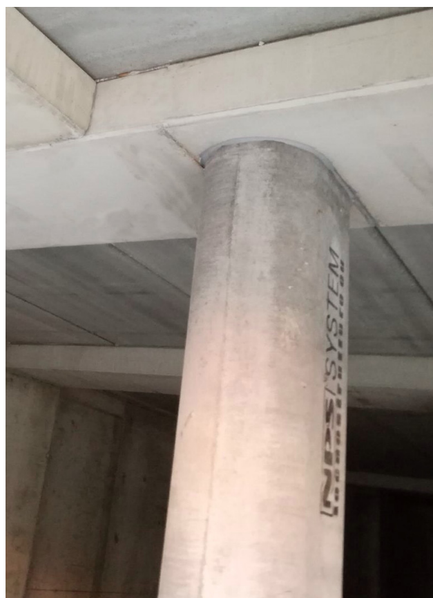
NPS® Core: dettaglio connessione di tra pilastro PTC® in cacestruzzo centrifugato e trave NPS® Cls
