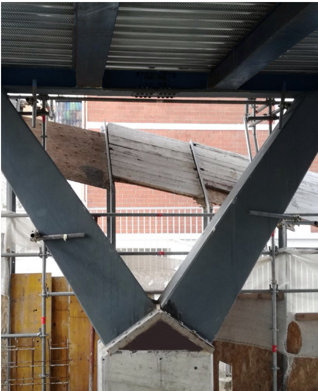
Abbinamento tra pilastro a V in carpenteria e travi miste acciaio-calcestruzzo NPS®
