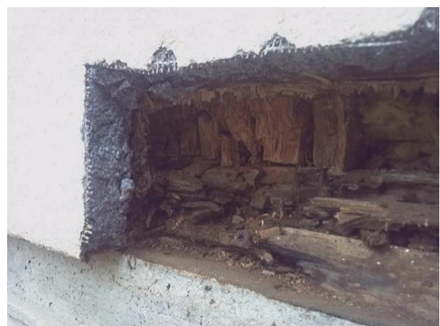
Fig. 1 & 2 - Degrado della parete in legno dovuto ad un'infiltrazione d'acqua proveniente dalla soglia della finestra soprastante
