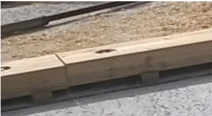
Fig. 6 & 7 - Rimedio “di fortuna” a compensazione della non planarità della platea e sistema di regolazione Airtech
