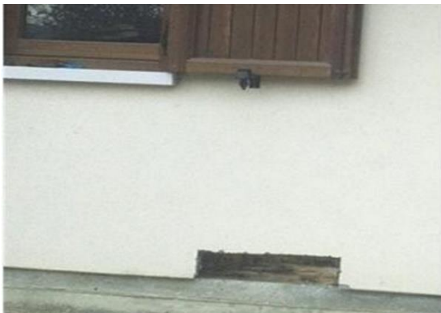
Fig. 1 & 2 - Degrado della parete in legno dovuto ad un'infiltrazione d'acqua proveniente dalla soglia della finestra soprastante
