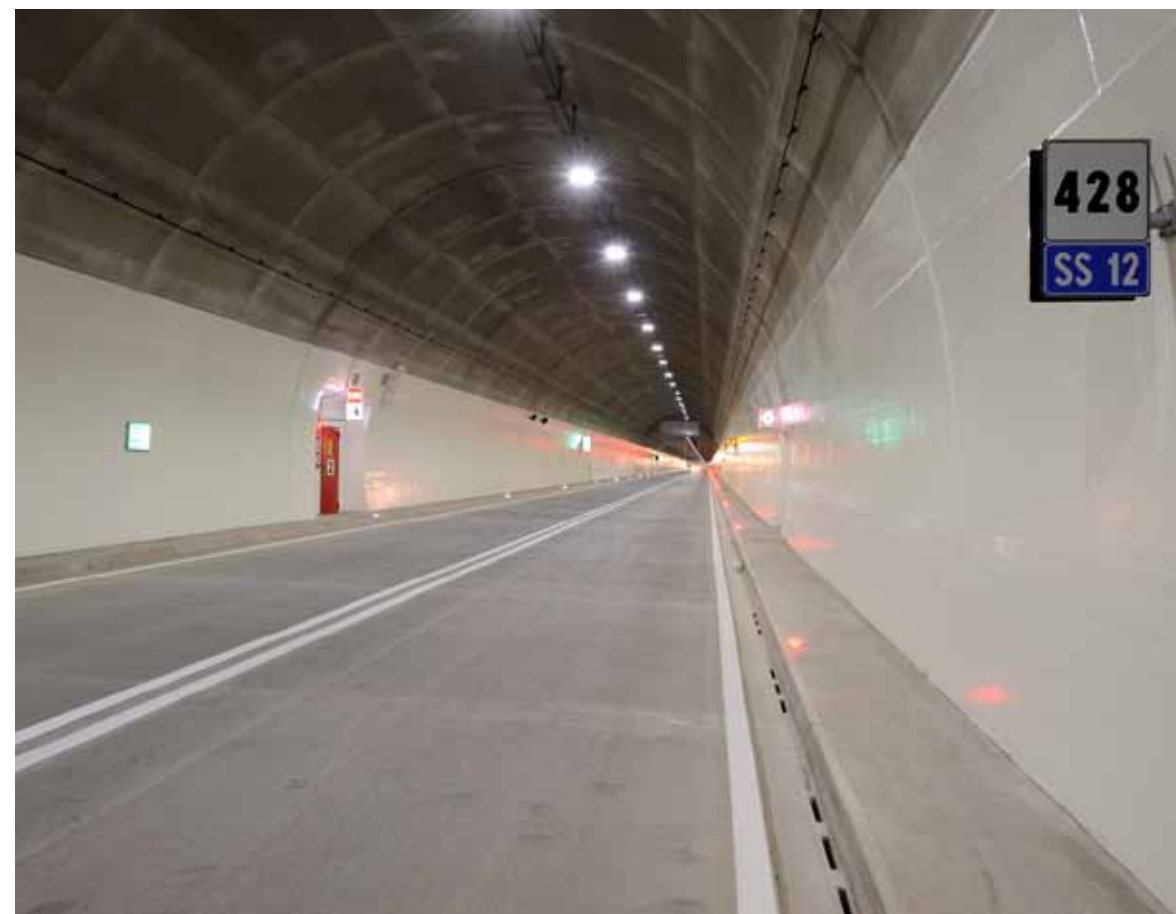
La Galleria Laives prima dell'apertura al traffico
