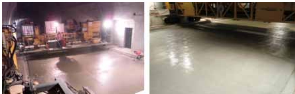
Operazioni finali di finitura della pavimentazione (a sinistra). Applicazione dell'additivo ritardante sulla pavimentazione finita (a destra).
