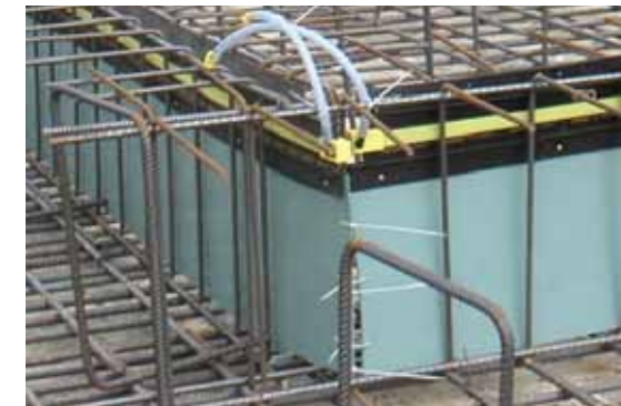
Figura 7. Elemento di prefessurazione
