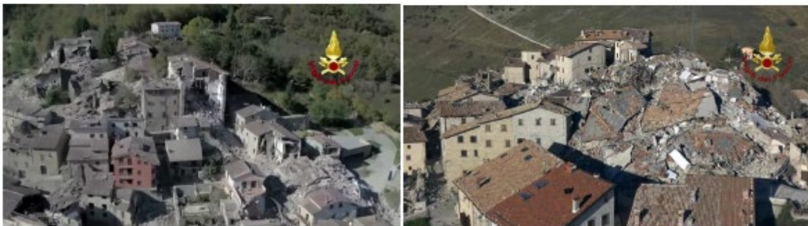
Effetti del sisma ad Accumoli e Castelluccio di Norcia
