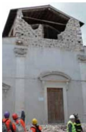
Figura 1c Chiesa di San Biagio d'Amiterno (AQ). Crollo parziale della facciata principale della chiesa; la copertura, in occasione di un intervento pre-sisma, è stata irrigidita attraverso l'inserimento di una soletta in cemento armato (terremoto de L'Aquila, 2009)
