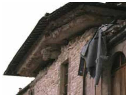
Figura 1a – Sellano (PG), 1997. Scorrimento del piano della copertura; in occasione di un intervento pre-sisma, la copertura tradizionale era stata sostituita con una copertura più rigida e pesante; nessun intervento di rinforzo era stato eseguito sulle strutture verticali in muratura (terremoto Umbria-Marche, 1997)
