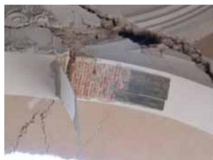
Figura 1d – Collasso di un arco nella Chiesa di San Marco a L'Aquila (AQ), causato dalla rotazione rigida dei soprastanti timpani, in cemento armato. Nell'immagine è possibile osservare il distacco delle fibre di carbonio applicate all'intradosso dell'arco in occasione di un intervento pre-sisma (terremoto de L'Aquila, 2009).
