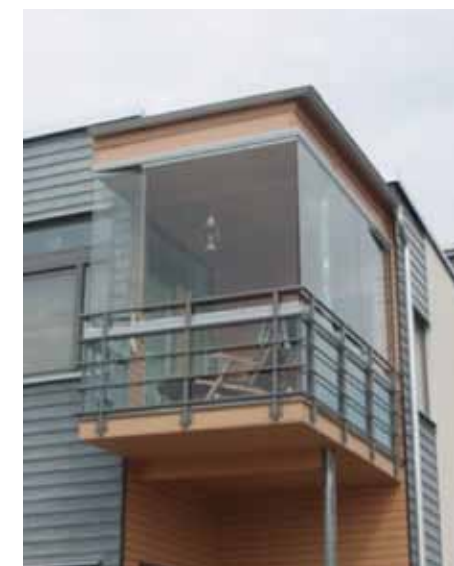
Esempio di loggia/balcone dotato di chiusure vetrate scorrevoli: il volume può essere utilizzato come serra solare nei mesi più freddi e fungere in tal modo da spazio "buffer".
