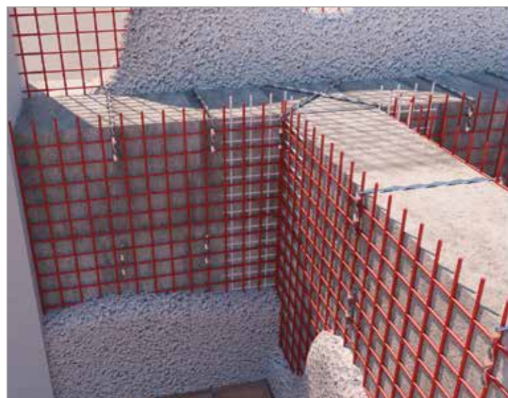
Figura 1 – Il consolidamento della parete del Castello di Trezzo sull'Adda (MI) mediante stralli in acciaio. Vista laterale
