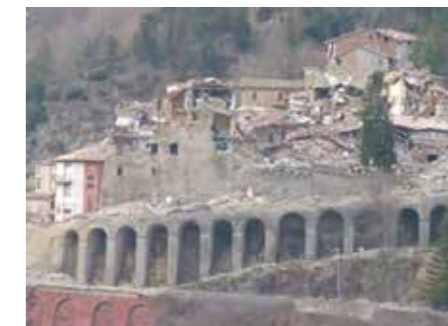
Figura 1 – Arquata del Tronto dopo la sequenza sismica iniziata il 24 agosto 2016
