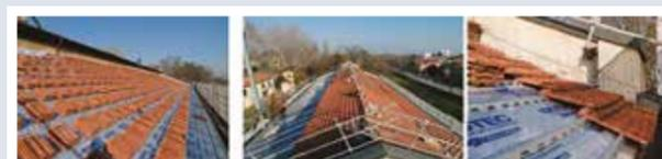
Un ruolo da protagonista nell'intervento di rifacimento della copertura è stato svolto dal **sistema termoisolante portante ISOTEC di Brianza Plastica**, scelto dai progettisti per le elevate prestazioni che il pannello offre in termini di **stabilità strutturale nel tempo**, oltre che per le proprietà funzionali di **seconda impermeabilizzazione** che tale soluzione offre in caso di problemi al manto di copertura.
