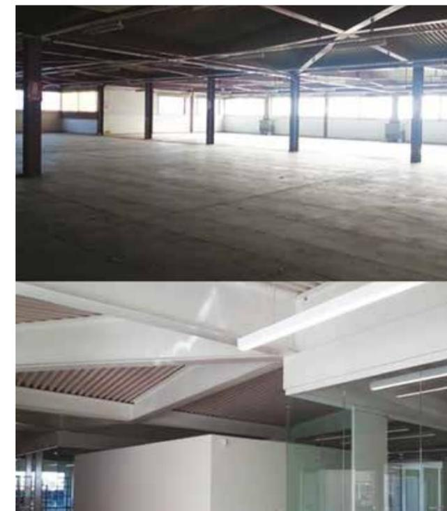
Punto di partenza per il nuovo edificio è dunque stata la **struttura in acciaio**, costituita da pilastri HEA 300 con travi IPE 600 e solai d'interpiano in lamiera grecata zincata tipo EGB sp. 10/10; in copertura sono presenti travi IPE di altezza variabile e lamiera grecata EGB 1000. >>>
