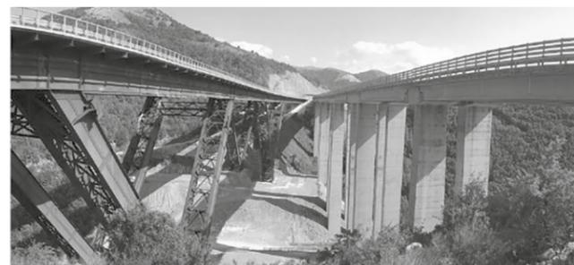
Figura 1 – Nuovo viadotto Caffaro (a sinistra), in affiancamento all'esistente da demolire
