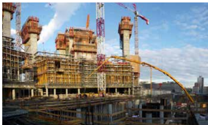
Figura 1 – Immagine del cantiere durante la realizzazione delle strutture in c.a.
