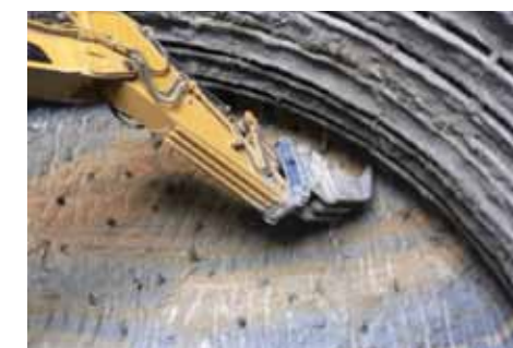
Figura 1 – Galleria Fiasco S.S. 106 Jonica in argille grigio-azzurre siltose Borgia(CZ)
