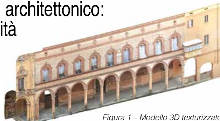
Figura 1 – Modello 3D texturizzato di palazzo Felicini ottenuto tramite fotomodellazione
