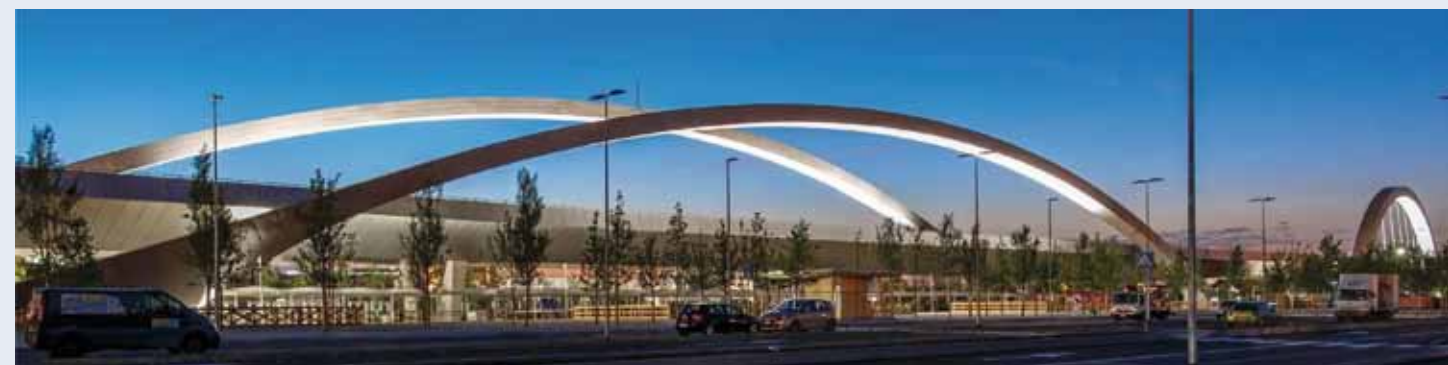
Figura 1 – Vista generale - Viadotto EXPO e ponte ad arco su A8 (foto G. Albo)
