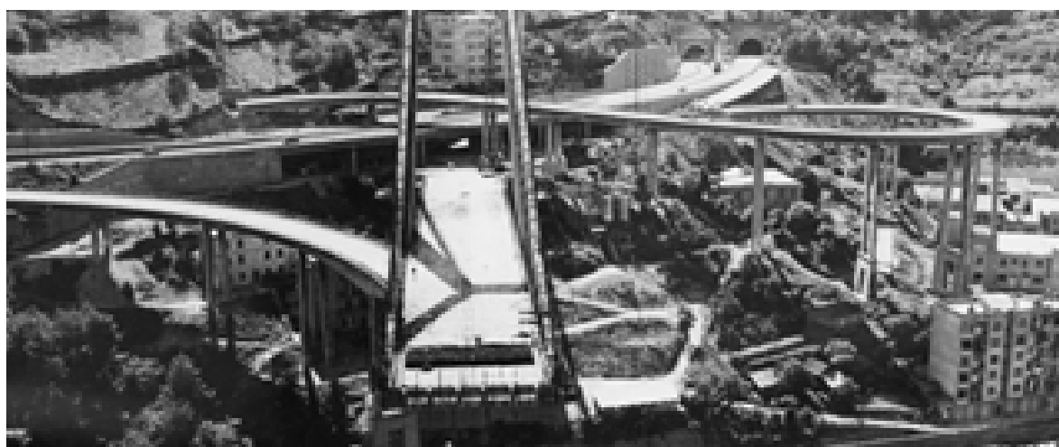
Vista aerea della rampa elicoidale in costruzione
