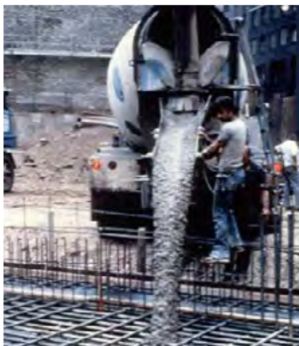
Getto del cls autolivellante per la fondazione della TRUMP TOWER (NY 1981) - Mix-design: M. Colleparidi
