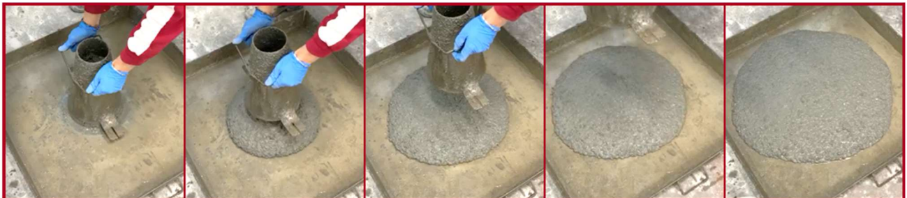
Figura 3 – Elevata lavorabilità e robustezza del betoncino strutturale STRUCTURE BF4-B
