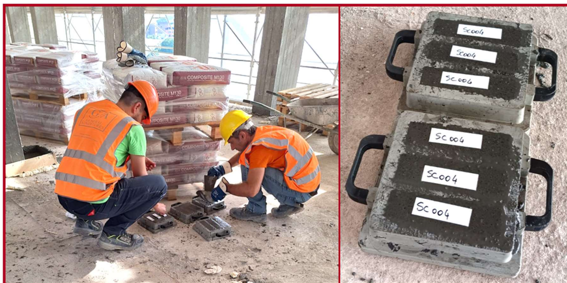
Figura 7 – Controlli di qualità ed assistenza in cantiere durante la posa in opera del COMPOSITE M130
