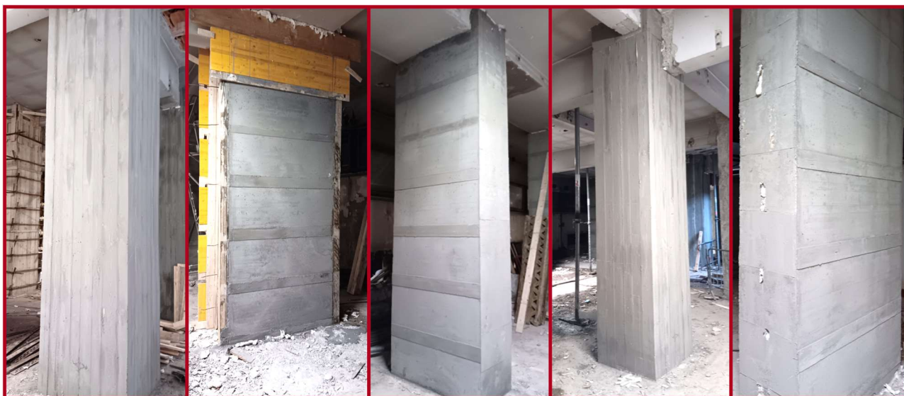
Figura 5 – Aspetto finale degli elementi rinforzati con incamiciatura in c.a. realizzata con betoncino premiscelato.
