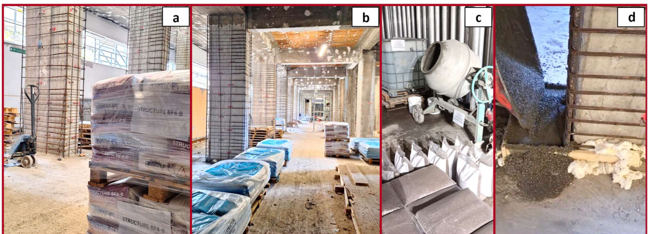
Figura 4 - Betoncino strutturale STRUCTURE BF4-B , dallo stoccaggio alla sua posa in opera
