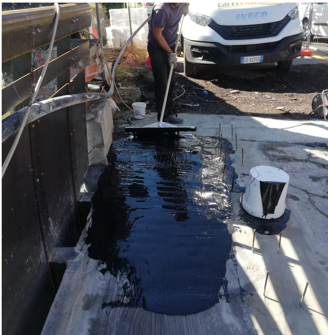
*Applicazione del rivestimento epossipoliuretano ELASTOPROOF, per l'impermeabilizzazione di un impalcato di ponte. - DRACO Italiana SpA*
