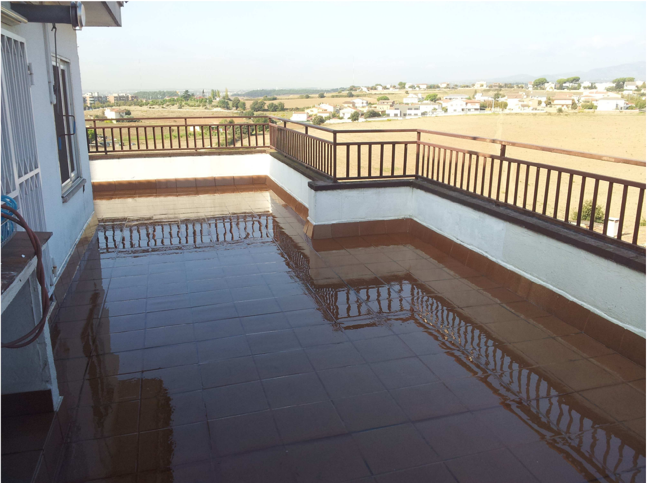
Figura 3 – Impermeabilizzazione “a vista” con FLEXIROOF, resina poliuretano monocomponente trasparente.
