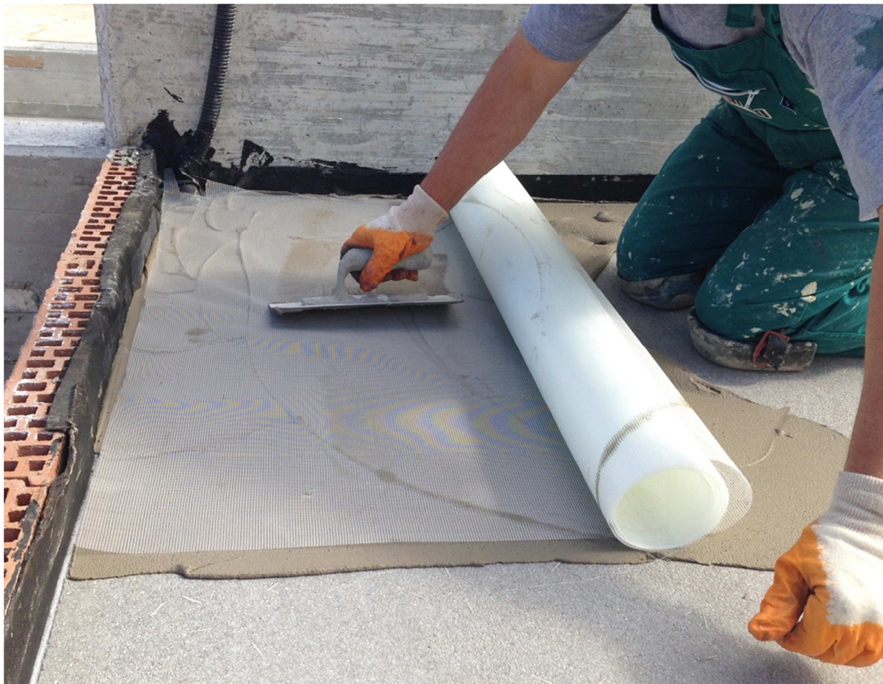
Figura 1 – Applicazione di MAGIFLEX a spatola ed inserimento della rete di rinforzo alcali-resistente in fibra di vetro MAGINET tra la prima e la seconda mano del prodotto.
