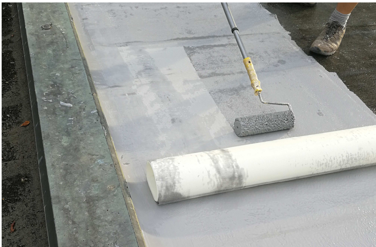
Figura 2 – Stesura a rullo di ELASTOCOATING EP e inserimento della rete di rinforzo alcali-resistente in fibra di vetro MAGINET sul prodotto ancora fresco.
