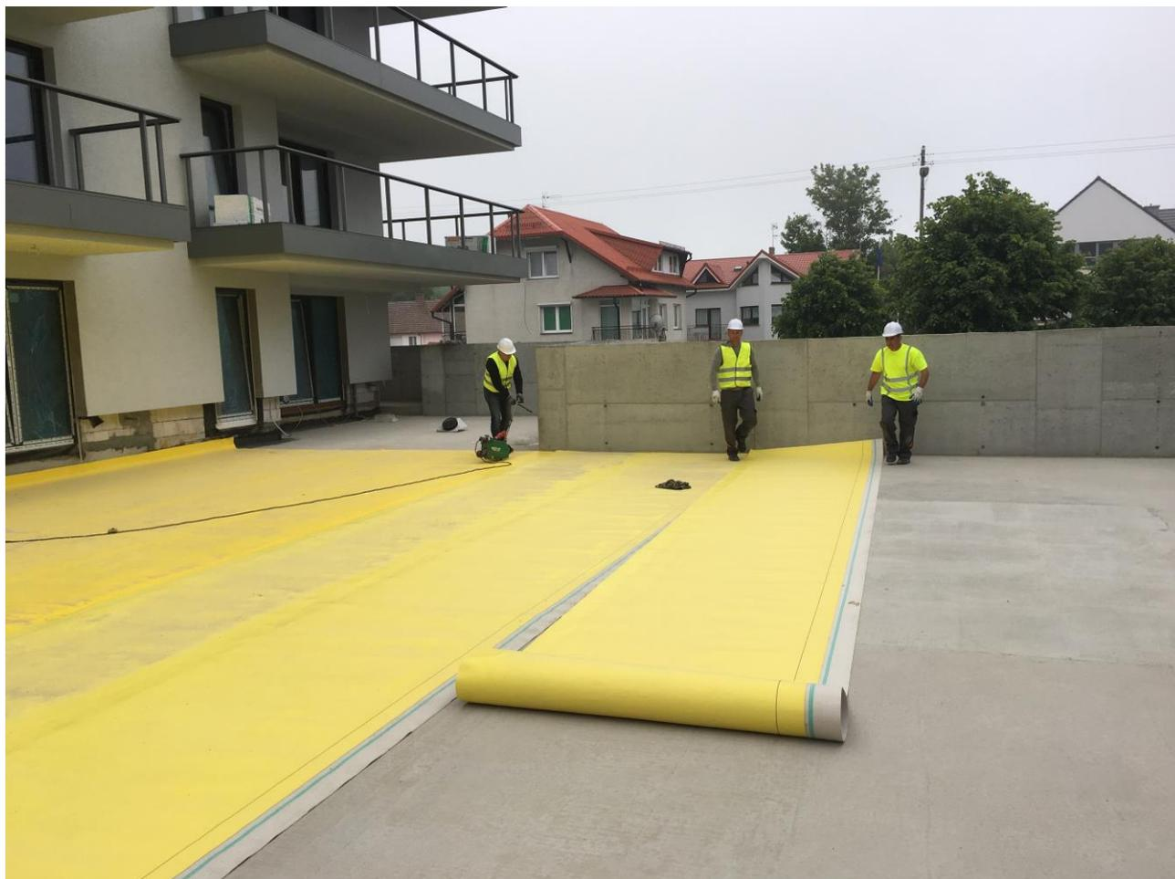
*Membrana impermeabilizzante termoplastica idro-reattiva COREFLEX XP.*
