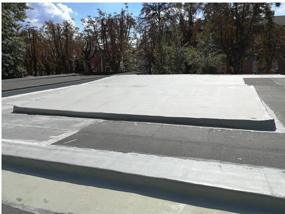
*Vecchia copertura in guaina bituminosa ripristinata con Elastocoating Ep.*
