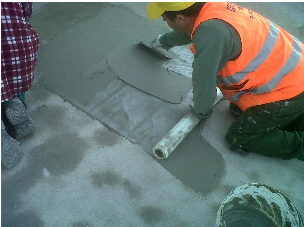
*Impermeabilizzante bicomponente cementizio Magiflex armato con rete in fibra di vetro Maginet.*
