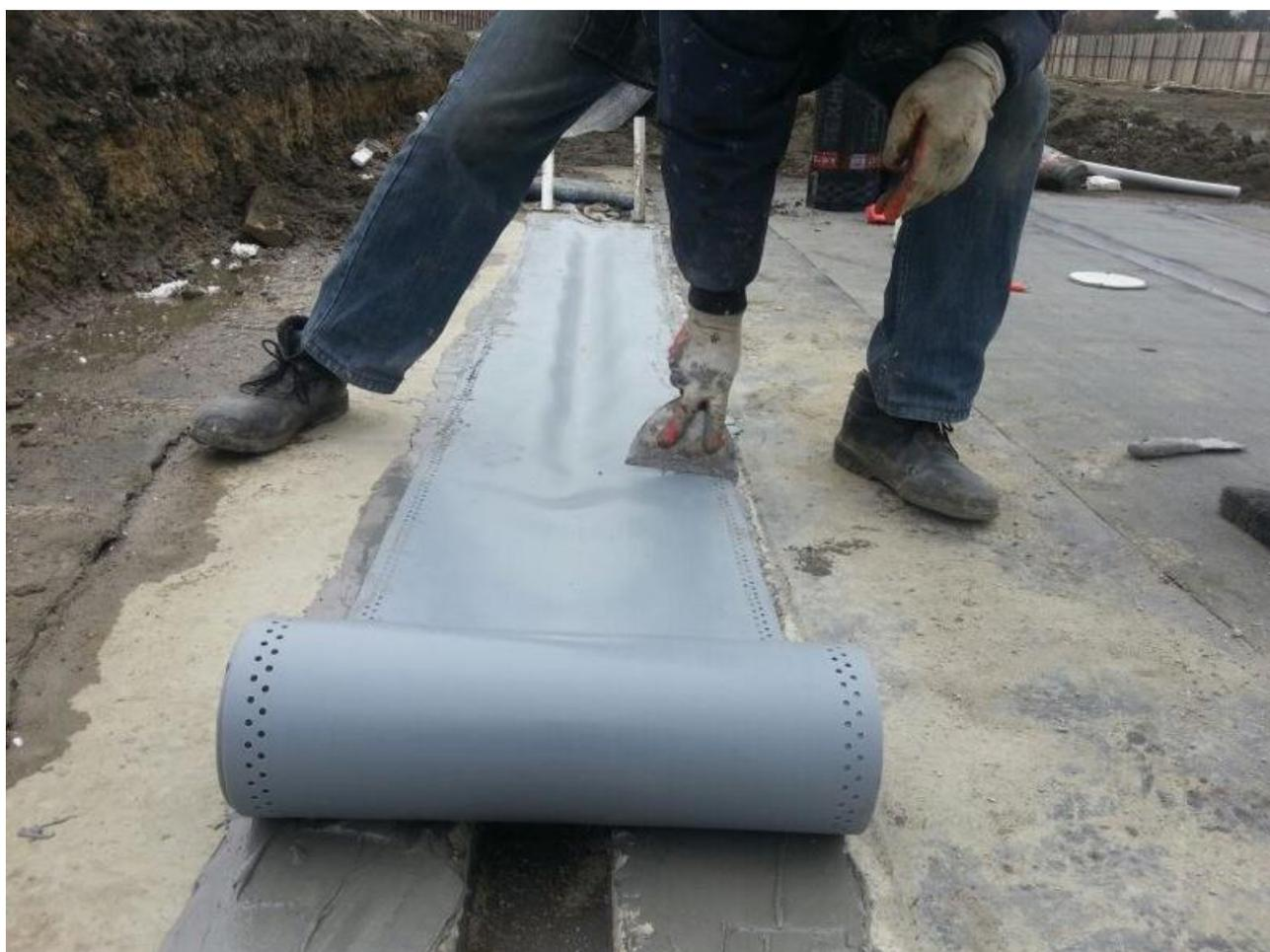
*Applicazione del nastro Flexijoint in combinazione alla resina epossidica strutturale Ep Fix Hp.*
