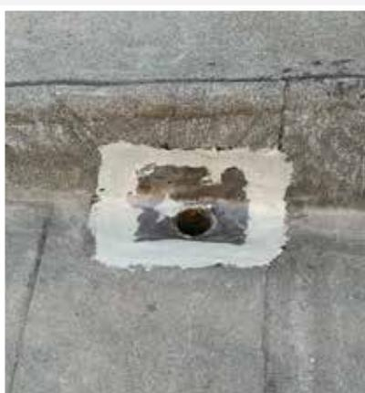
In primo luogo si è provveduto alla riparazione della superficie con EP FIX FAST, un adesivo epossidico bicomponente in pasta specifico per riparazioni rapide e incollaggi strutturali, particolarmente idoneo ai climi freddi (5-18°C).
