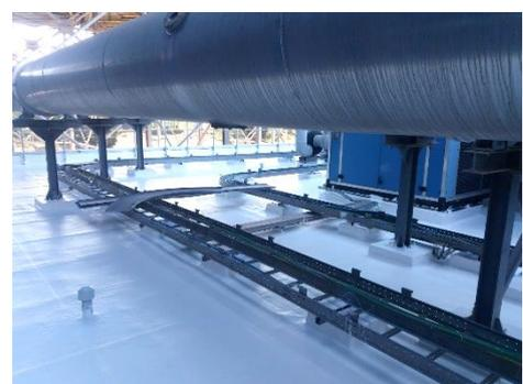
*Figura 15 - Re-impermeabilizzazione vecchia guaina su copertura industriale in esercizio*
