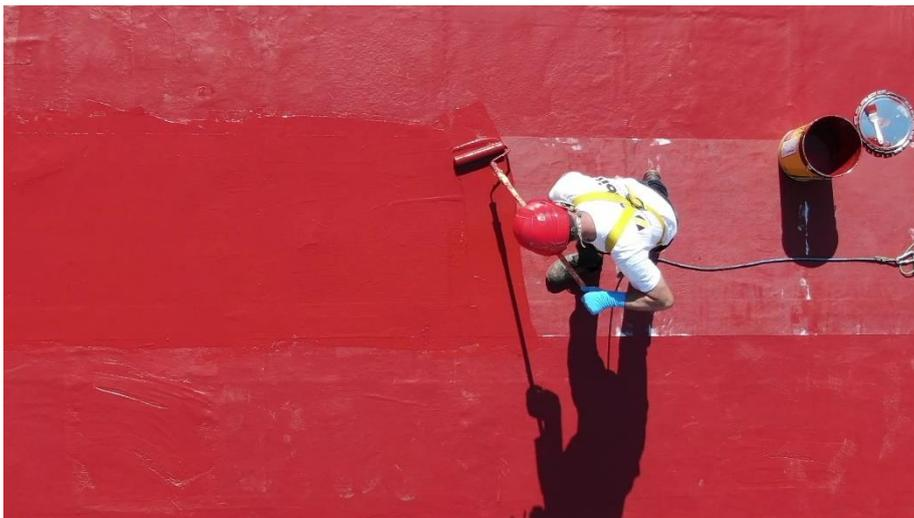
Figura 11 - Impermeabilizzazione di una vecchia guaina bituminosa con Keep Dry di Icobit
