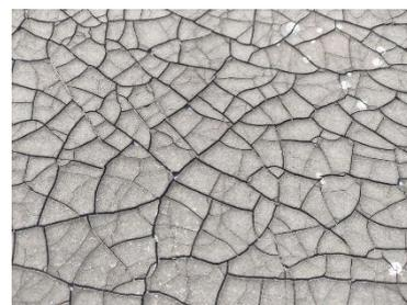
Figura 3 - Coccodrillatura di una vecchia guaina a rotoli
