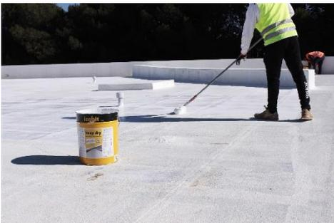
*Figura 12 - Recupero vecchia guaina bituminosa con Keep Dry Bianco Ostuni ad elevata riflessione solare*
