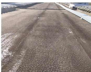
Figura 2 - Stato di degrado di una guaina bituminosa
