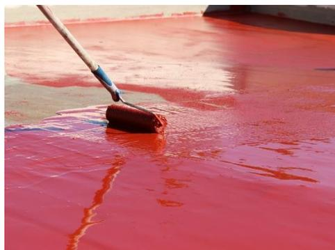
Figura 5 - Applicazione di un impermeabilizzante liquido Icobit
