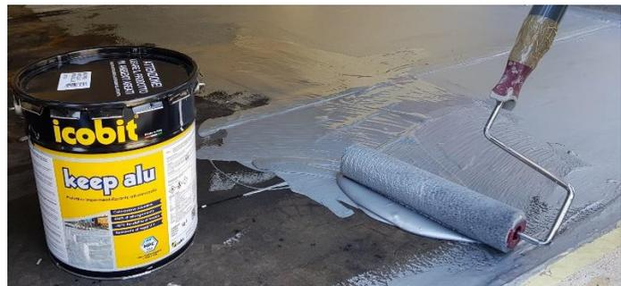
*Figura 13 - Ripristino manto bituminoso con Keep Dry metal Alluminio*
