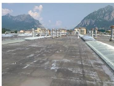
Figura 1 - Condizioni di una guaina bituminosa esistente
