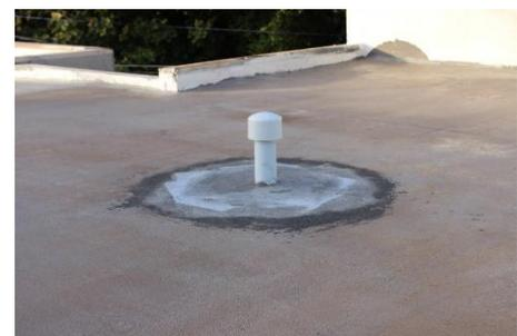
Figura 10 - Installazione esalatore di vapore Exit Air di Icobit
