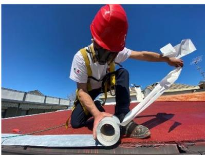
Figura 9 - Applicazione bandella butilica Butyl Tape di Icobit
