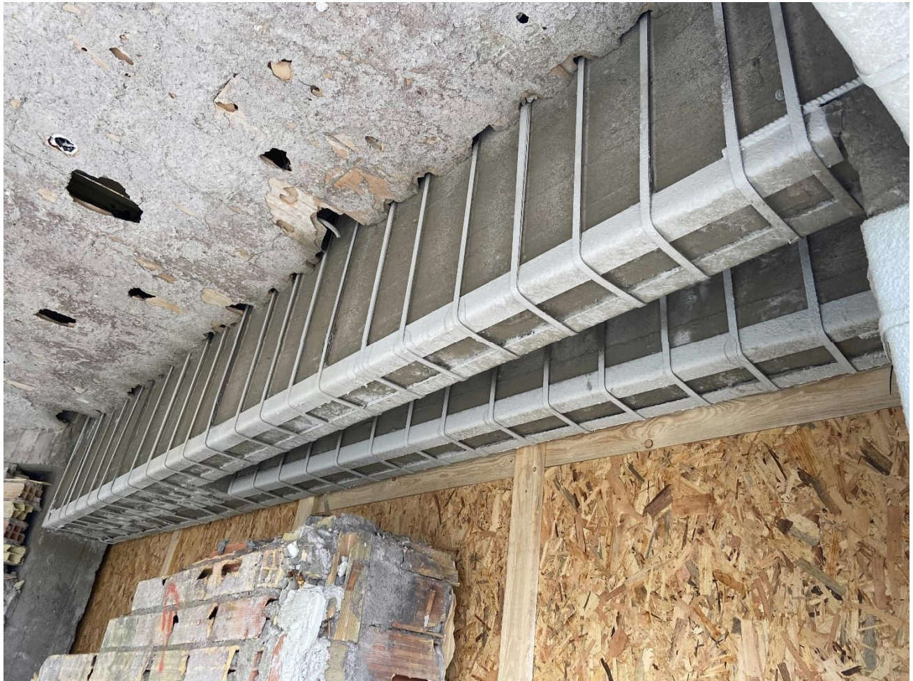
Dettaglio dell'intervento in vicinanza dell'appoggio
