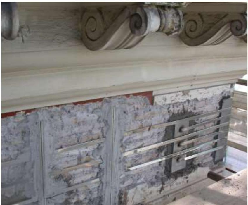
sopravvivenza alle azioni sismiche, la soluzione mediante “maglia tridimensionale”, nella quale ovviamente ricade il CAM<sup>®</sup>, **viene di fatto considerata l’unica veramente applicabile**, salvo che nello specifico caso in cui non sia presente l’intonaco.
