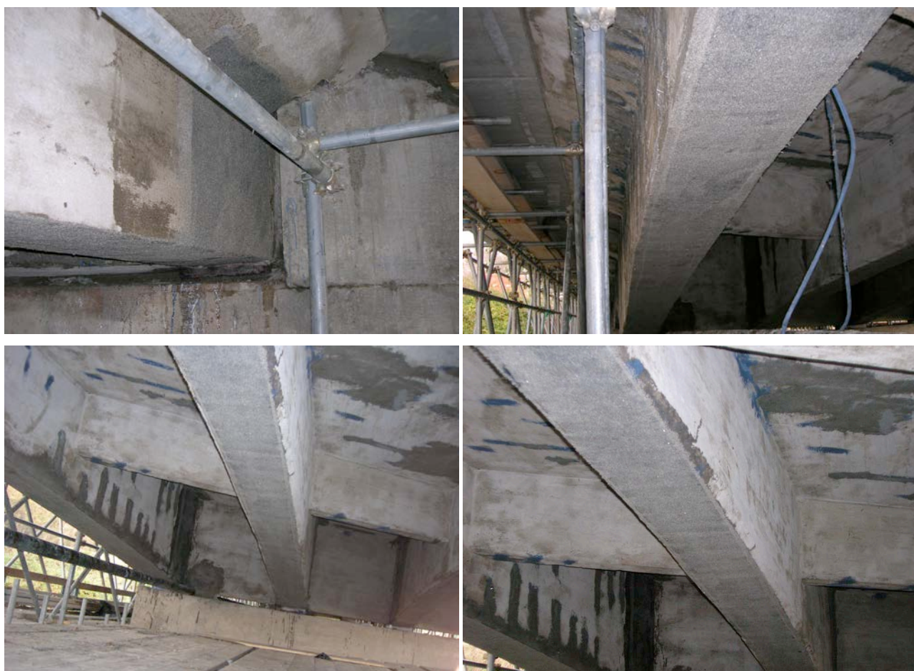
Rinforzi per ripristinare la capacità portante strutturale.
