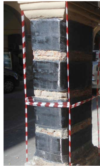
Confinamento di muratura.
