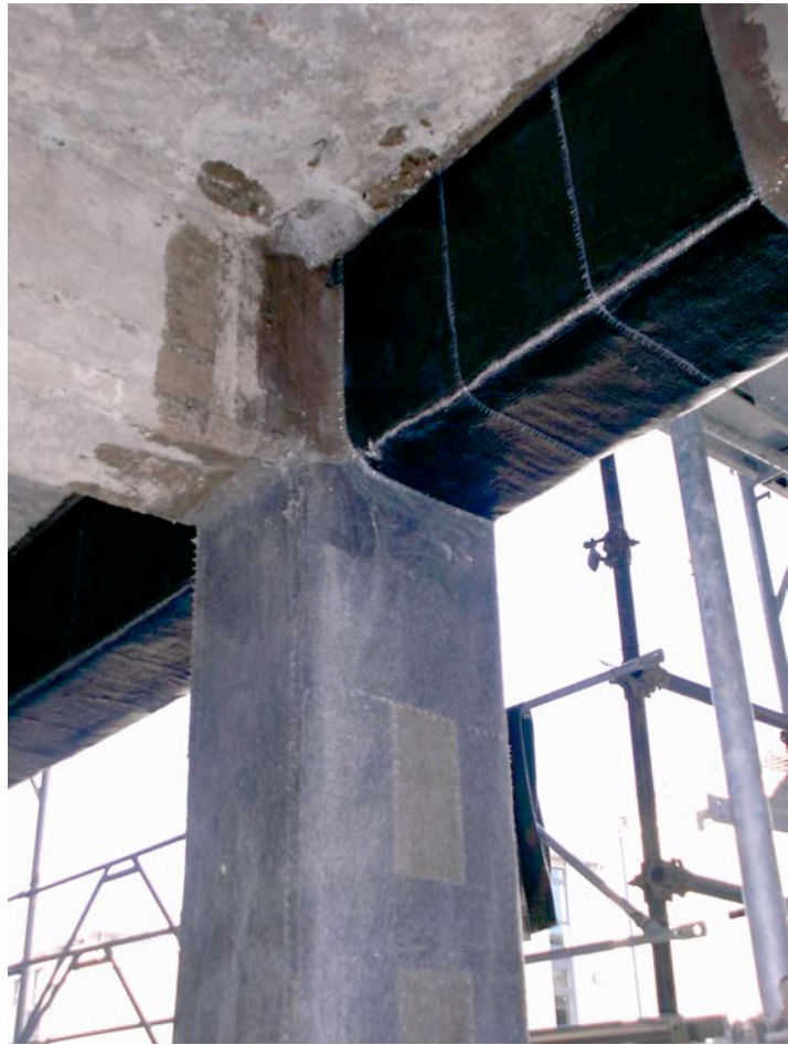
Rinforzi per modificare il meccanismo di rottura.
