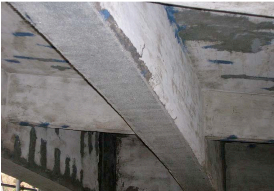
Rinforzi a flessione.
