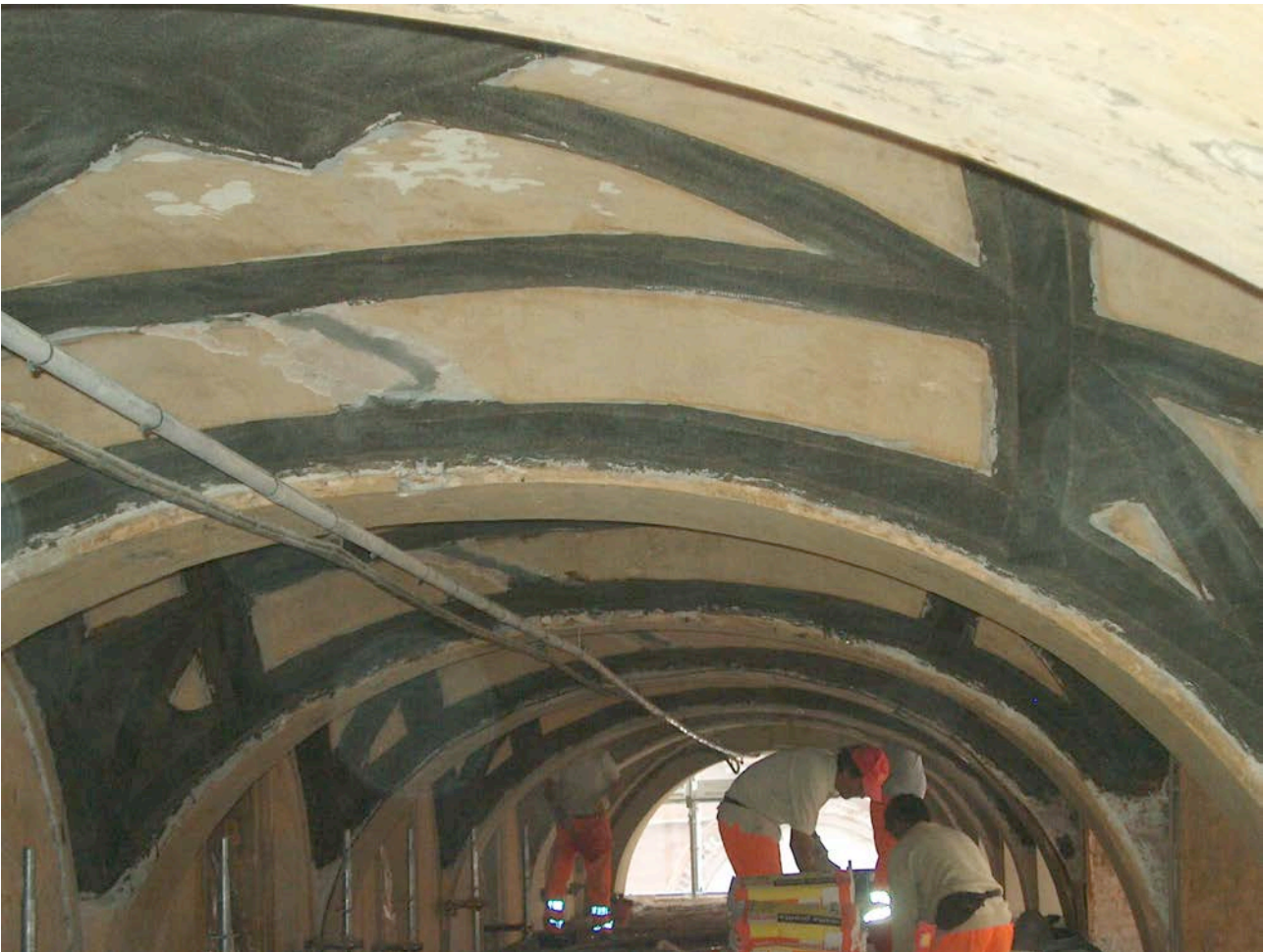
Rinforzo intradossale di volte. IN ALTO AL CENTRO: vista del risultato estetico finale.
