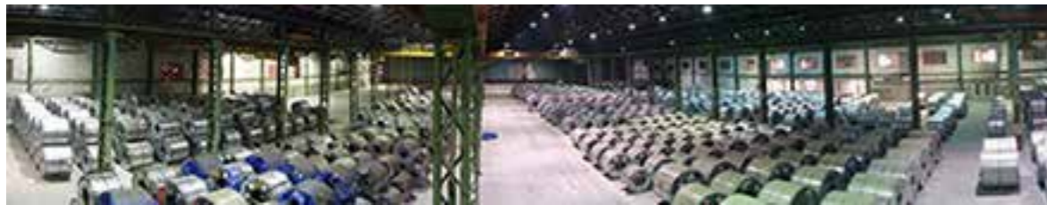
Figura 1. Vista panoramica della pavimentazione post-tesa nel Magazzino 7 "Multiservice" a Marghera (VE)
