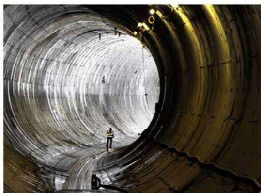
Figura 1. Rivestimento definitivo in conci prefabbricati
