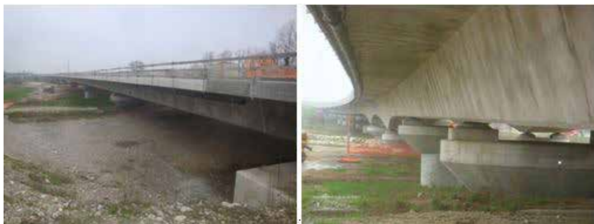
Viadotto Oglio: Impalcato e Pile
