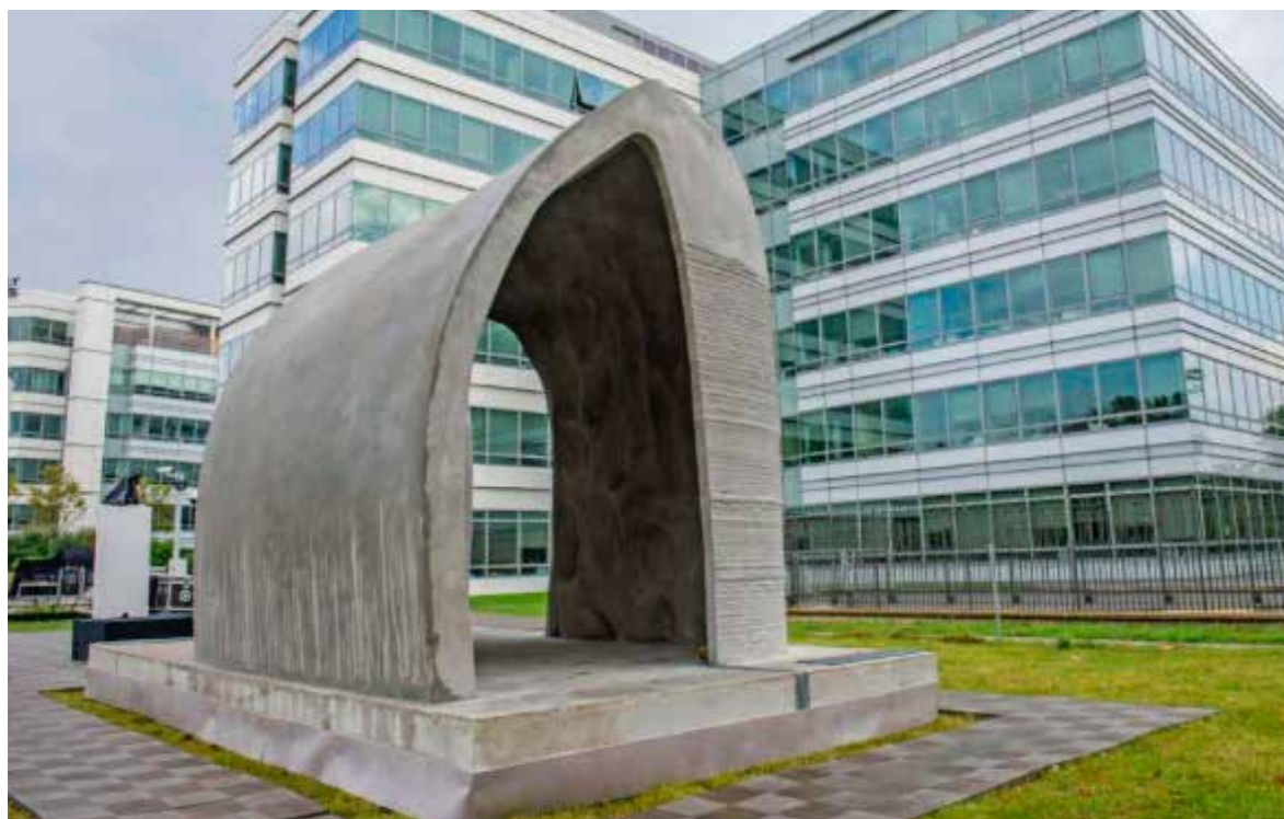
XtreeE a Imprimé son pavillon en 3D à Vélizy-Villacoublay (Yvelines). Photo Dassault Systèmes
