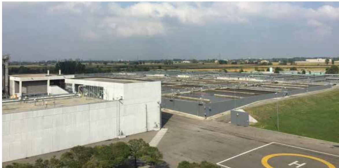
Depuratore Sud di Milano, Rozzano
