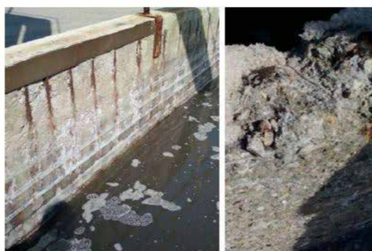
Figura 1 – Perdita di massa conseguente ad un attacco chimico
