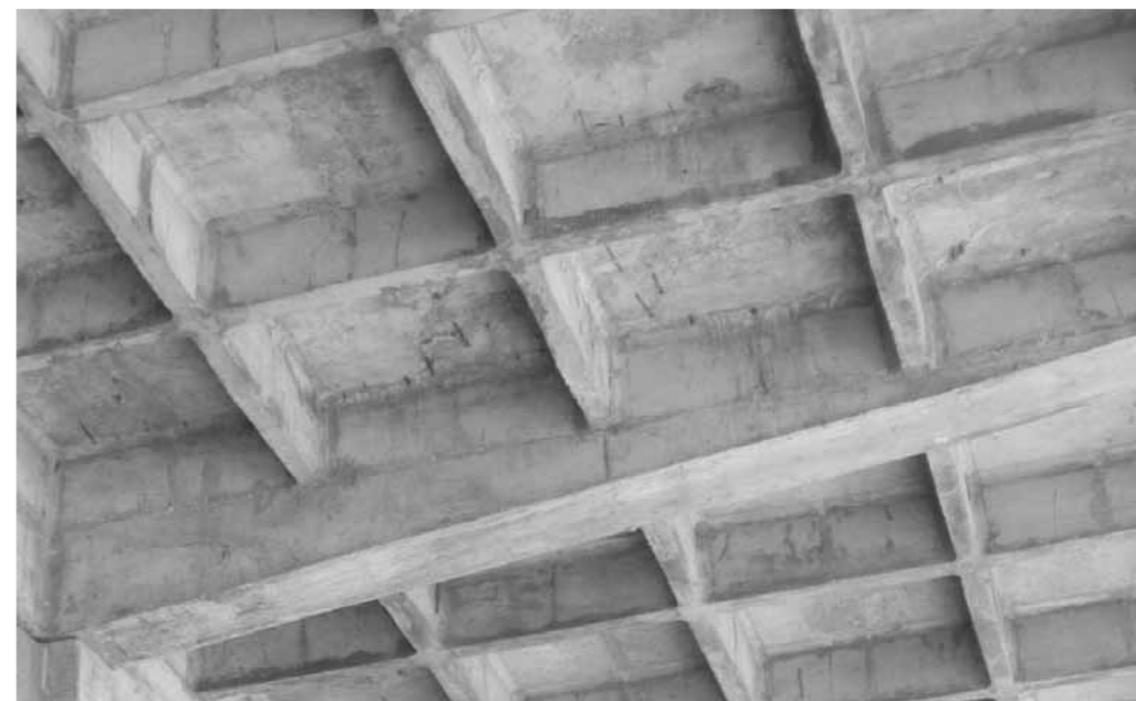
Figura 1. Evidenti forme di degrado del calcestruzzo a vista
