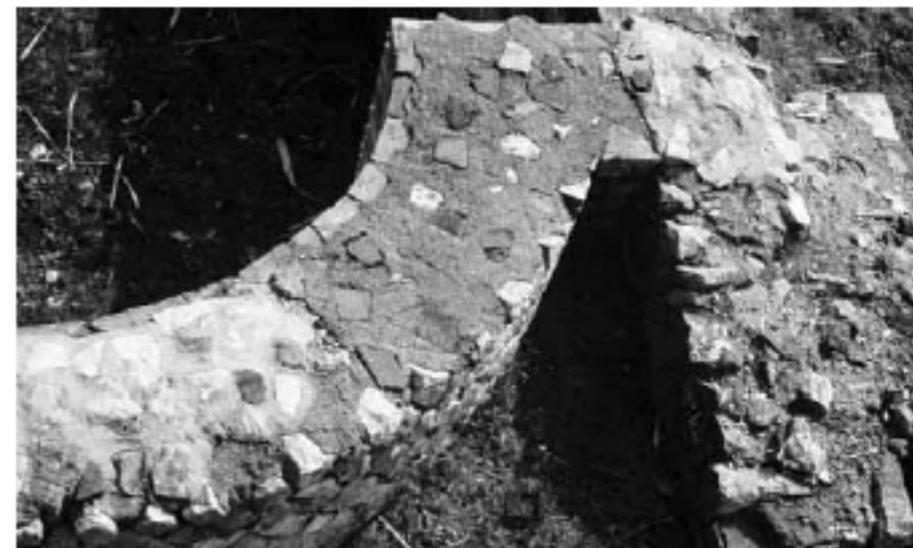
**Figura 1.** In pochi metri di muro c'è una ricca campionatura di interventi di protezione delle creste. Più o meno accettabili, possono costituire la base per valutare gli interventi di altra epoca e decidere futuri interventi di manutenzione
