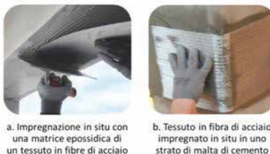
Figura 2. Modalità di impregnazione in situ dei sistemi
