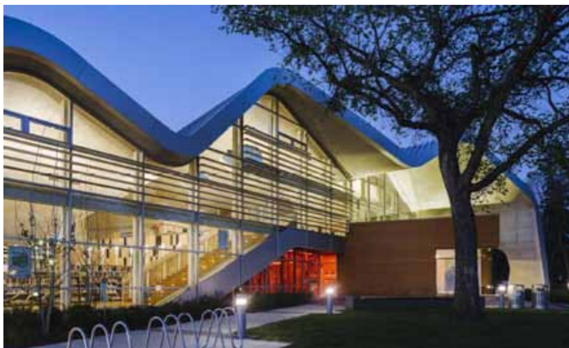
Figura 3. Jasper Place Branch Library, Edmonton, Alberta, Canada, HCMA & Dub Architects, 2013 – Vista dell'edificio durante le ore serali. La copertura in calcestruzzo armato grazie alle sue caratteristiche strutturali permette di liberare gli spazi interni e le facciate longitudinali realizzate in vetro.
