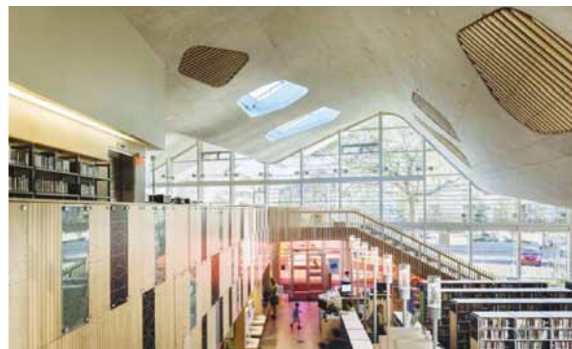
Figura 4. Jasper Place Branch Library, Edmonton, Alberta, Canada, HCMA & Dub Architects, 2013 – Vista degli spazi interni della libreria. La copertura sinuosa disegna al suo interno delle parabole architettoniche, un'onda continua caratterizzata da aperture che permettono l'ingresso della luce attraverso un guscio in calcestruzzo.
