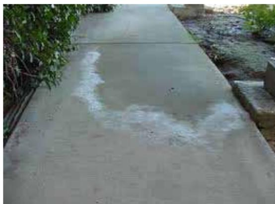
**DOMANDA:** Abbiamo una lastra di cemento colorato, realizzato da poco più di un anno in un cortile esterno, che è diventato scolorito, con la presenza di macchie bianche e sostanze in superficie. Abbiamo provato a rimuovere la sostanza mediante l'applicazione di acqua e aceto e con il lavaggio con getto d'acqua in alta pressione, senza però avere successo.
