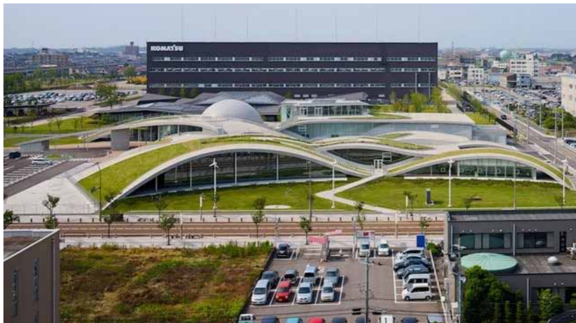
Figura 2. Science Museum and Communication Center, Komatsu, Ishikawa, Japan, Mari Ito/UAO, 2013 –Vista generale dell'edificio. La fluidità e le sinuosità delle curve definiscono gli spazi esterni ed interni
