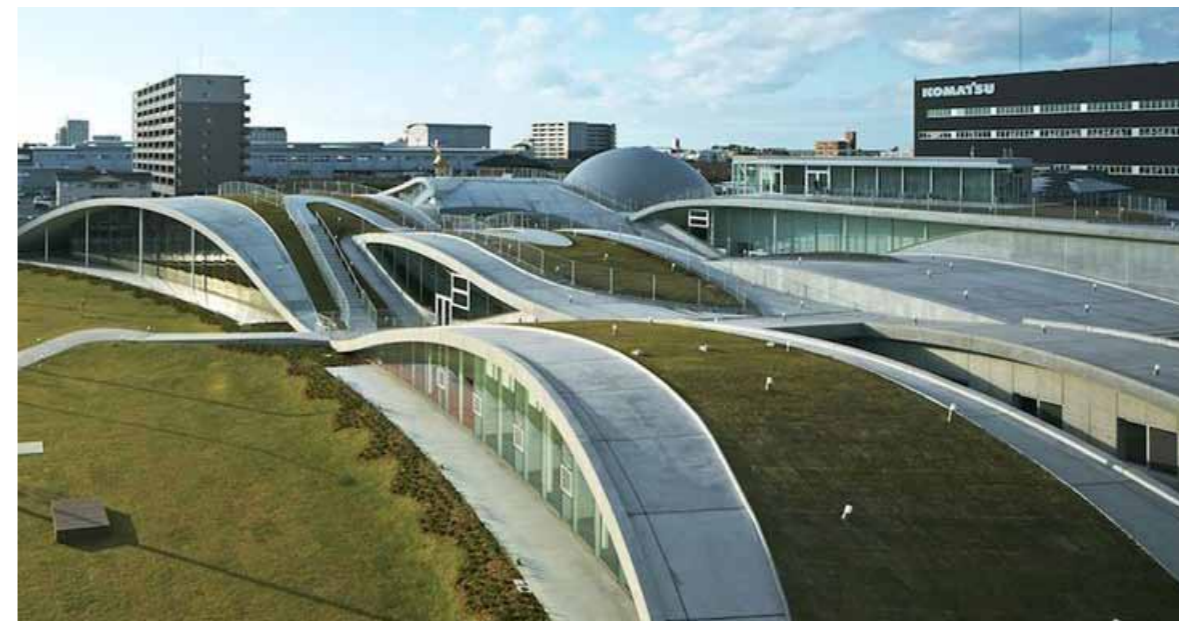
Figura 1. Science Museum and Communication Center, Komatsu, Ishikawa, Japan, Mari Ito/UAo, 2013 – Vista generale dell'organismo architettonico. Il Museo di Scienza e Centro Direzionale si sviluppa in un edificio descritto da diverse curve paraboliche realizzate in calcestruzzo armato con coperture verdi
