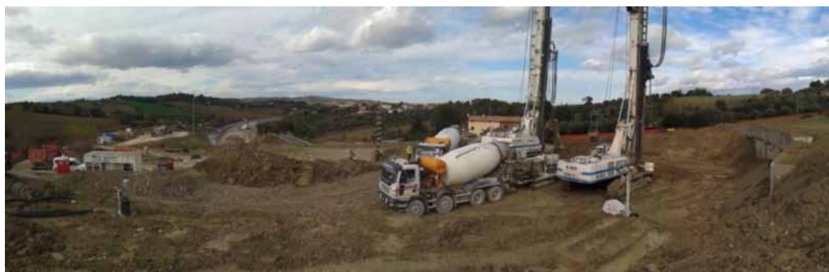
Foto 1. Fase di perforazione e getto
