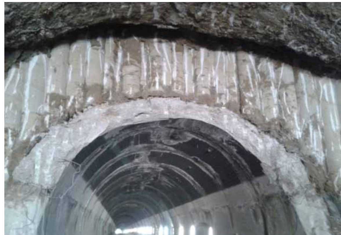
Foto 2. Vista consolidamento con pali CSP
