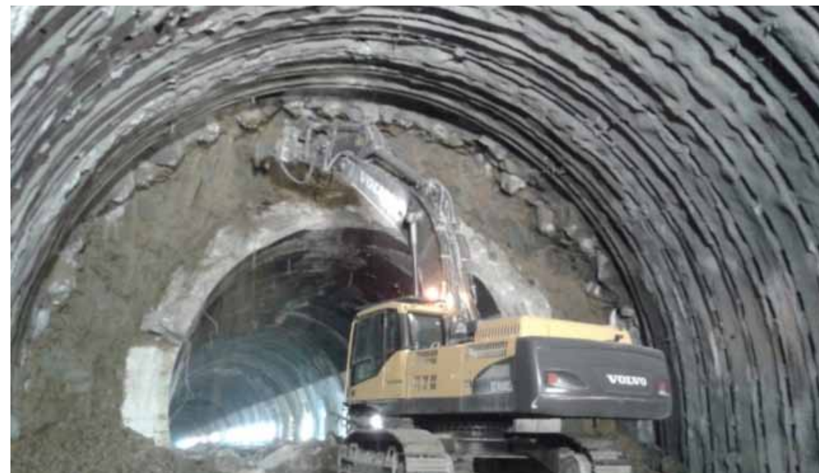
Foto 3. - Fase di scavo con demolizione pali e rivestimento galleria esistente
