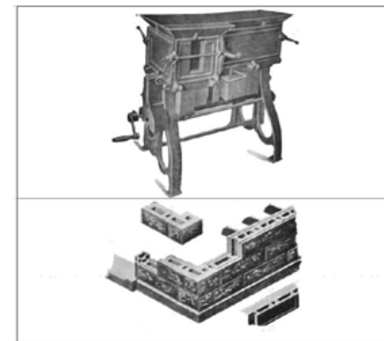
Figura 1. Immagini tratte dalla rivista "Il cemento" del 1904, raffiguranti un apparecchio brevettato dall'Harmon S. Palmer per la realizzazione in serie di blocchi in conglomerato cementizio, lavorati in superficie ad imitazione della pietra naturale
