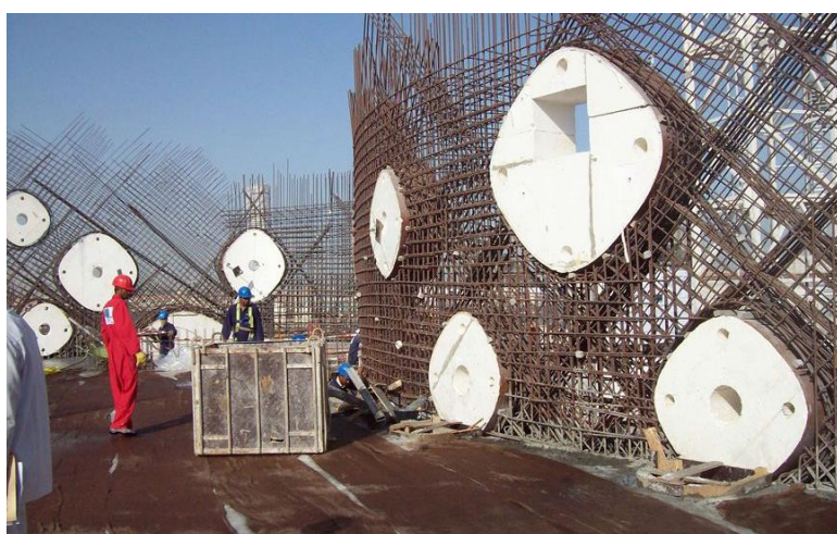
Figura 2. O-14, edificio per uffici, Dubai, United Arab Emirates, Reiser + Umemoto Architects – Vista della realizzazione dello scheletro in calcestruzzo gettato in opera.
