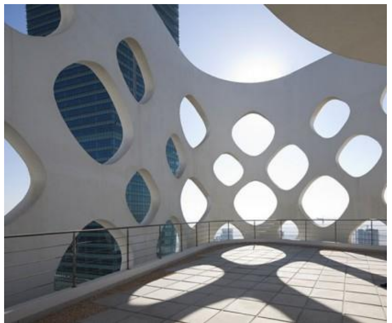
Figura 9. O-14, edificio per uffici, Dubai, United Arab Emirates, Reiser + Umemoto Architects – Vista generale dell'intervento, particolare della doppia pelle in calcestruzzo dell'ultimo piano
