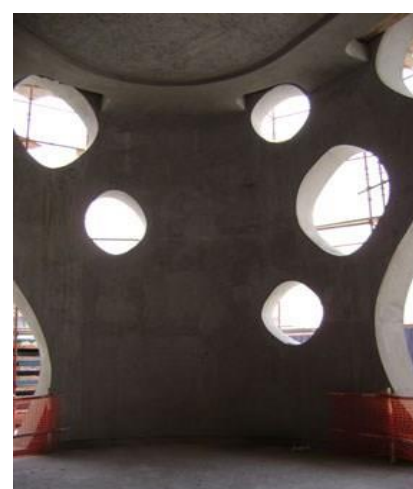
Figura 2. O-14, edificio per uffici, Dubai, United Arab Emirates, Reiser + Umemoto Architects – Vista della realizzazione dello scheletro in calcestruzzo gettato in opera.
