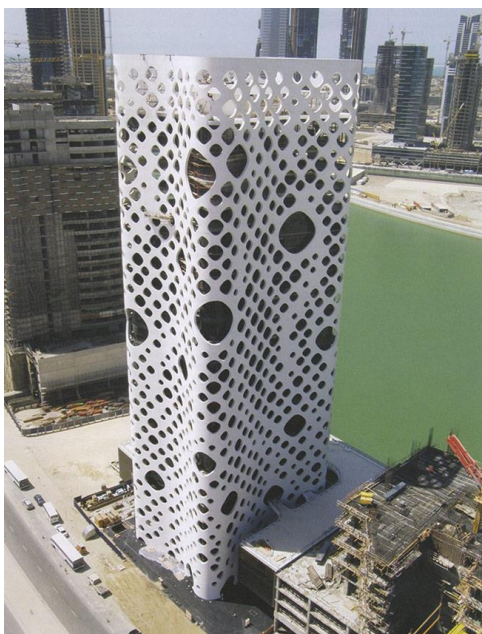
Figura 9. O-14, edificio per uffici, Dubai, United Arab Emirates, Reiser + Umemoto Architects – Vista generale dell'intervento, particolare della doppia pelle in calcestruzzo dell'ultimo piano
