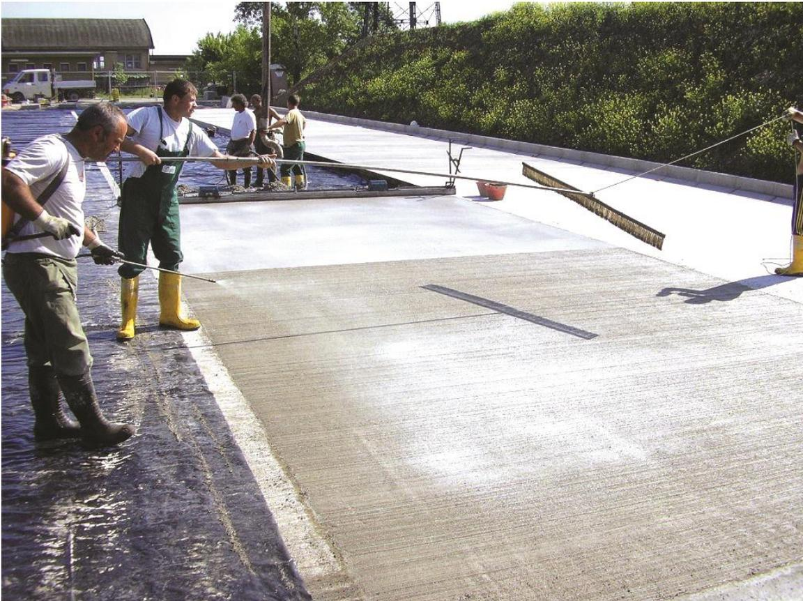
*Applicazione di PROBETON CURING N su calcestruzzo ancora umido.*
