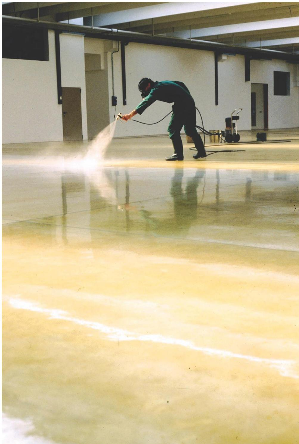
*Applicazione di EPOCURING sopra a una pavimentazione industriale.*
