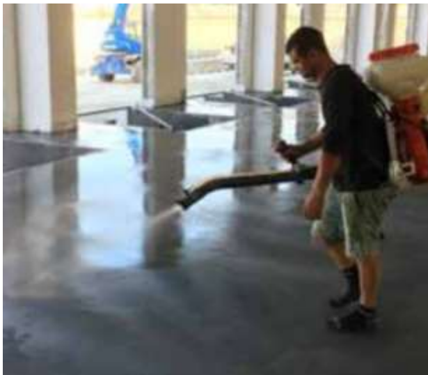
Figura 17 – Fase applicativa (nebulizzazione) di prodotti a base di silicati (Linea FLOOR PROTECT di General Admixtures) a protezione della pavimentazione finita.
