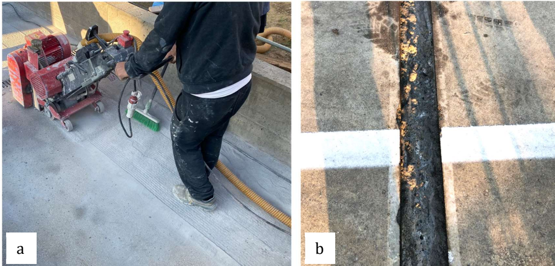
Figura 11 – Preparazione del supporto in caso di intervento generalizzato (a) o localizzato (b).
