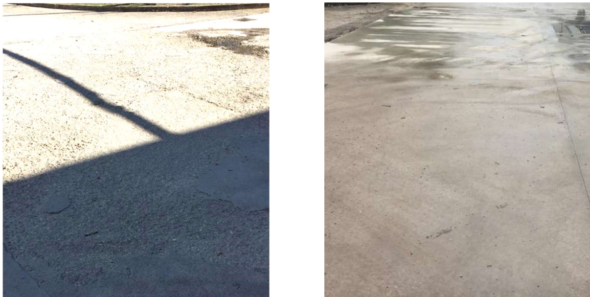
Figura 5 – Ripristino superficiale (generalizzato) di una pavimentazione in calcestruzzo ad uso produttivo.
