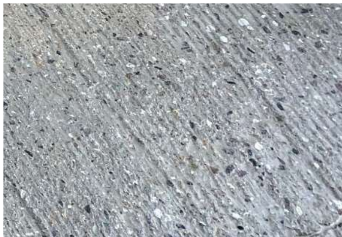
Figura 12 – Particolare dell’aspetto del supporto dopo una corretta preparazione: scarifica, pulizia e saturazione.
