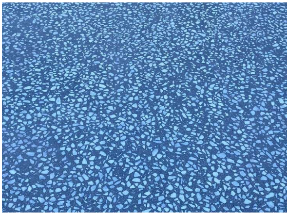
Figura 9 – Dettaglio dell'aspetto finale di una pavimentazione esterna realizzata con malta STRUCTURE PAV MF4-S integrata con aggregati bianchi selezionati.
