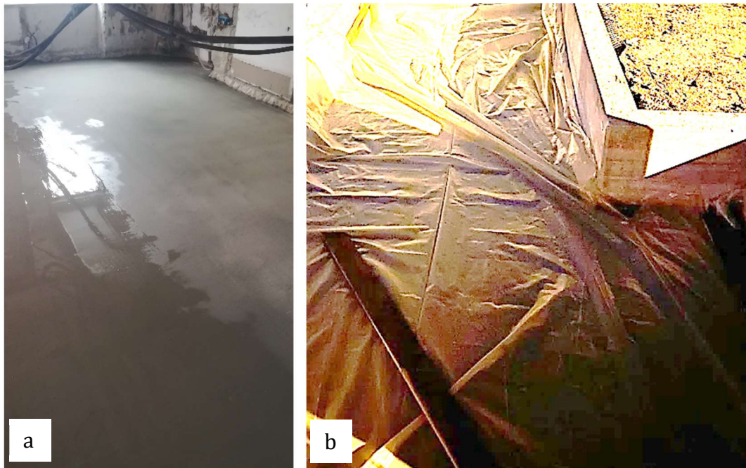
Figura 15 – Rapido sviluppo delle resistenze (a) con tempestivo ripristino delle attività di esercizio. Subito dopo la posa in opera si dovrà provvedere ad una adeguata stagionatura umida delle superfici (b).
