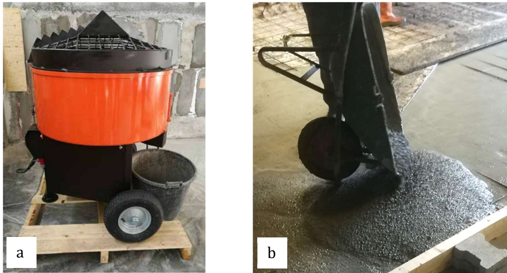
Figura 13 – Miscelazione della malta (a) e posa in opera in consistenza superfluida (b).
