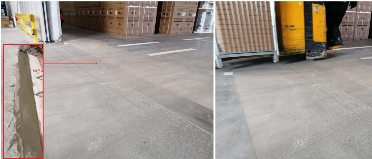
Figura 6 – Ripristino superficiale (localizzato) di una pavimentazione in calcestruzzo ad uso produttivo.
