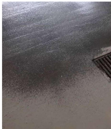
Figura 17 – Fase applicativa (nebulizzazione) di prodotti a base di silicati (Linea FLOOR PROTECT di General Admixtures) a protezione della pavimentazione finita.
