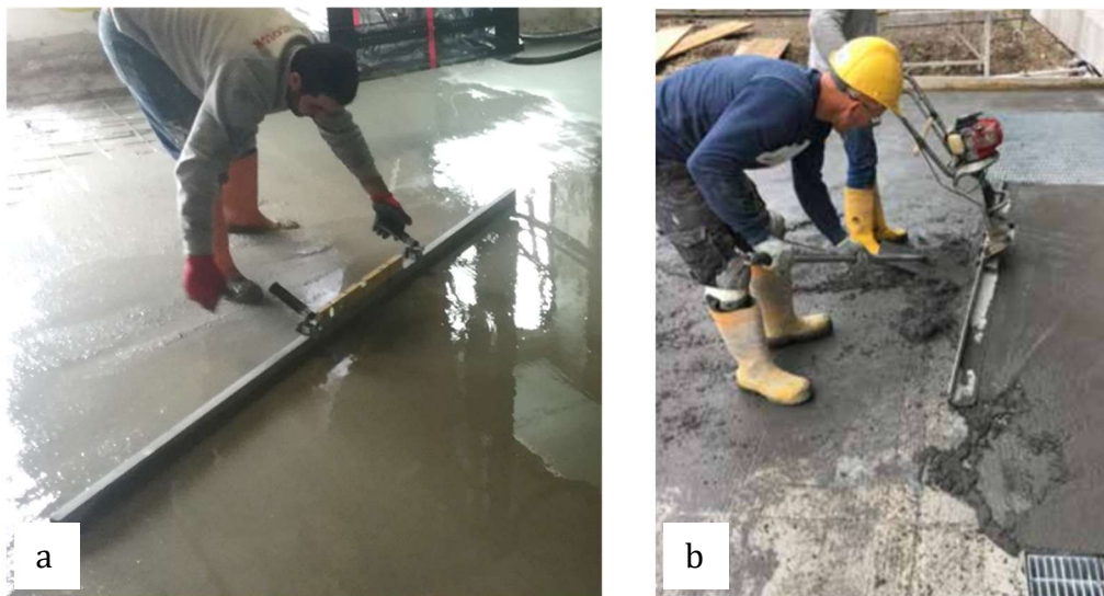
Figura 14 – Livellamento della malta con staggia in alluminio (a) o vibrostaggia (b)
