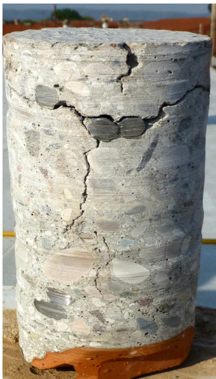
Tipica fessura presente su quasi tutta l'area del solaio
