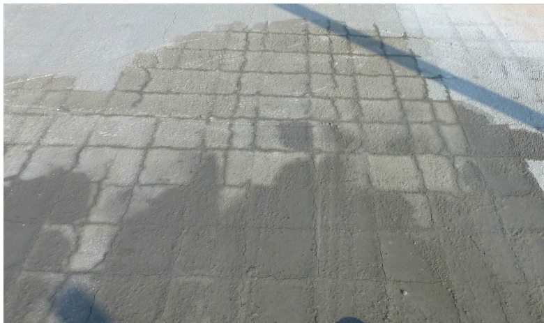
Le fessure riprodotte la griglia della rete d'armatura
