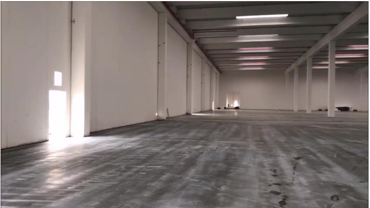
Figura 9. Vista della pavimentazione ultimata
