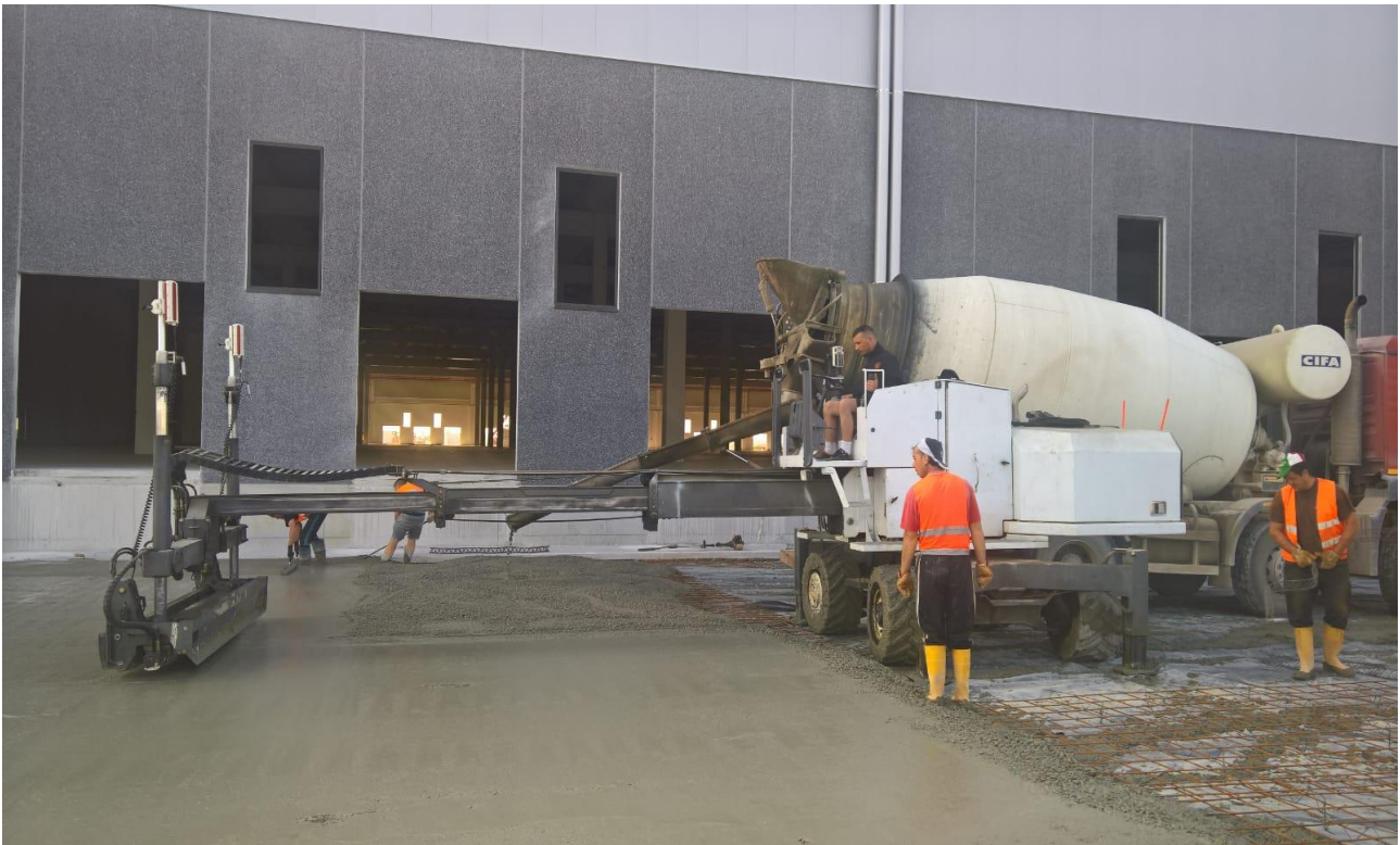
Figura 6. Fasi di getto della pavimentazione con stesa meccanizzata Laser Screed
