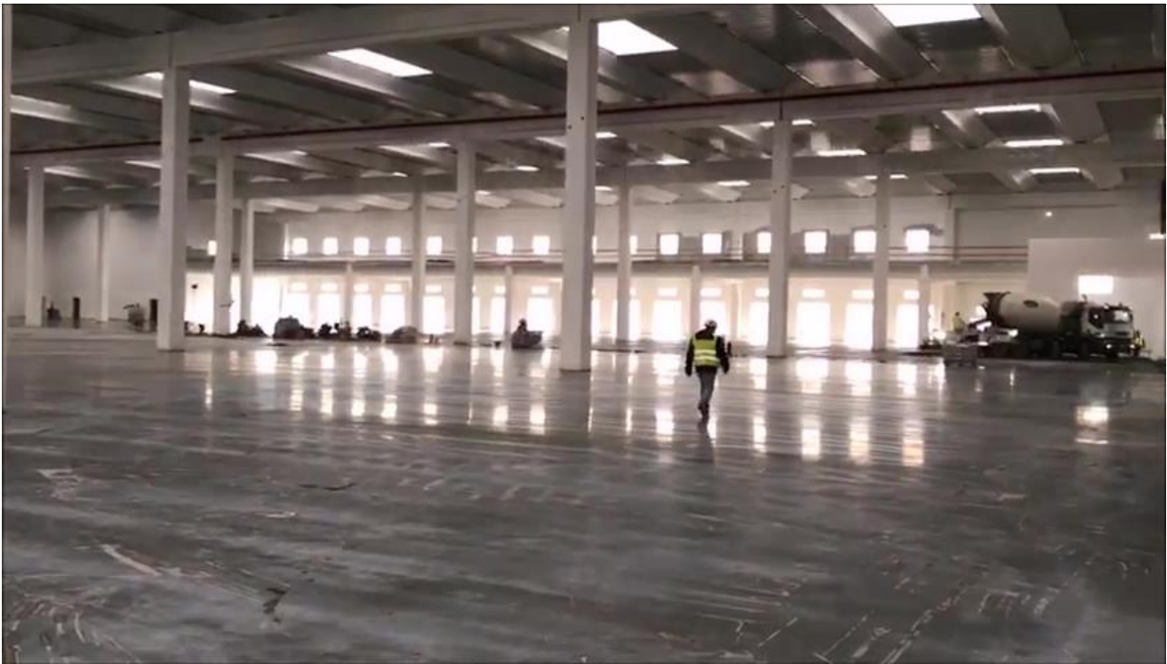
Figura 10. Vista della pavimentazione ultimata
