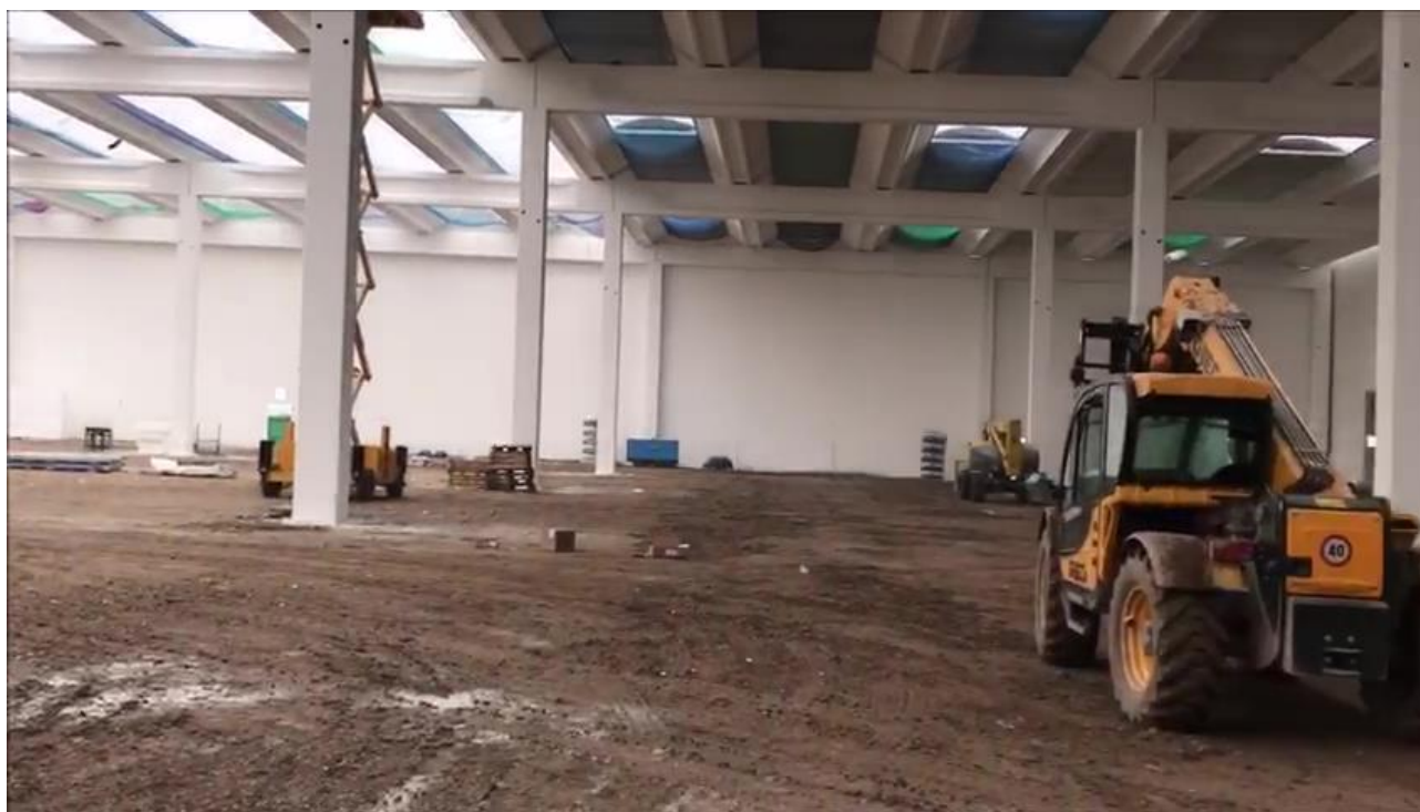
Figura 3. Preparazione del sottofondo
