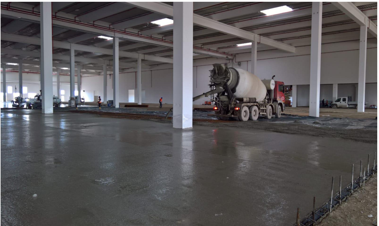
Figura 5. Fasi di getto della pavimentazione
