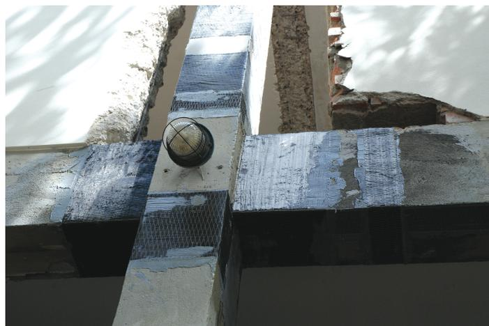
*Esempio del processo di cerchiatura nodo trave - pilastro con fasce in carbonio ARMOSHIELD C-SHEET.
