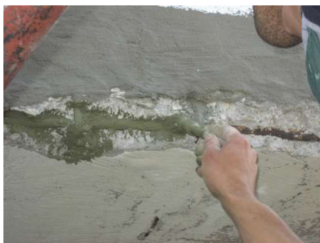
Particolare di ferro di armatura trattato con Dracosteel Mono
