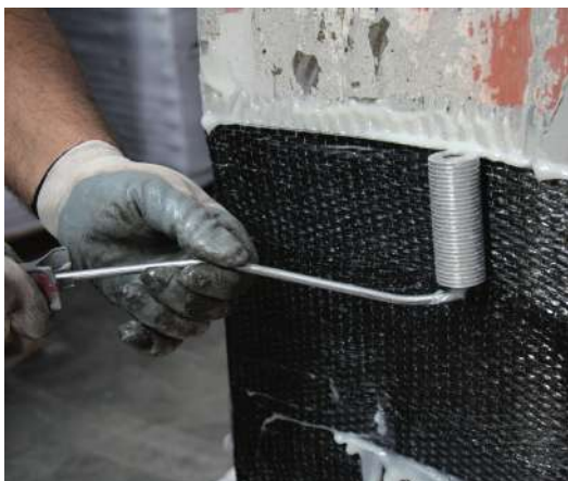
Impregnazione del tessuto con resina Armofix MTX mediante rullo metallico Armoroller.
