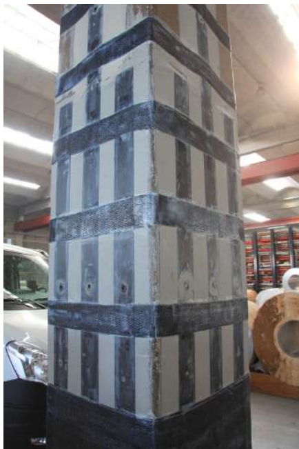
Esempio di applicazione di fasce in carbonio su pilastro.
