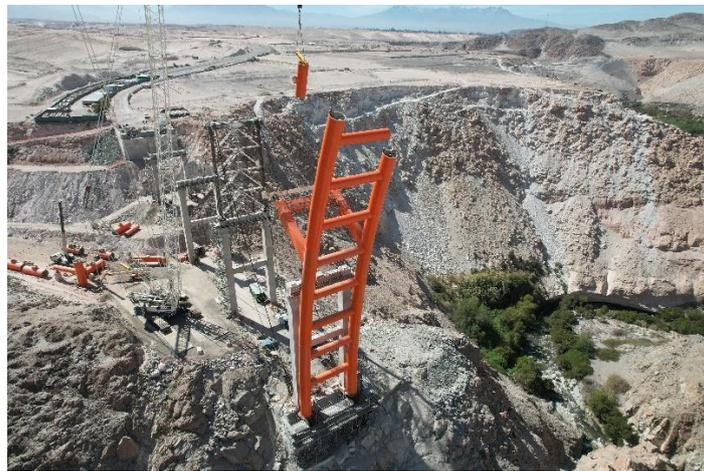
Fig. 12 –Fase di montaggio rampante dei conci dell'arco su cerniera provvisoria (Crediti Cimolai)
