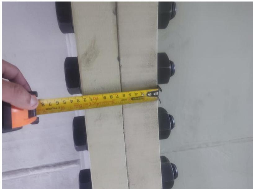
*Fig. 15 – Particolare della precisione di assemblaggio della flangia centrale thk60mm e bulloni M36-10.9 (Crediti Cimolai)*
