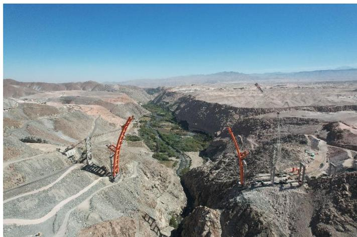
Fig. 13 –Fase finale del montaggio dei conci dell'arco rampante (Crediti Cimolai)
