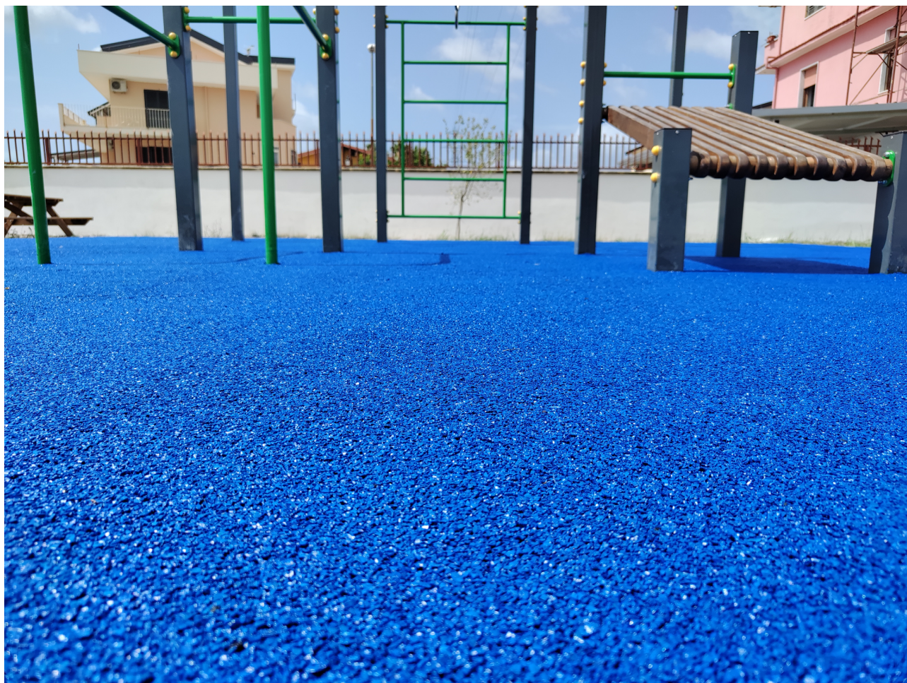
Pavimentazione realizzata con DRACOFLOOR SAFEPLAY
