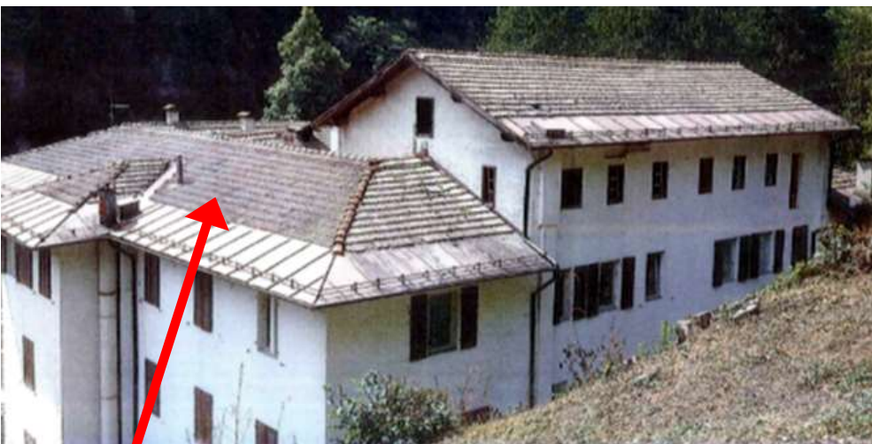
Copertura con 13 capriate di diverso tipo
