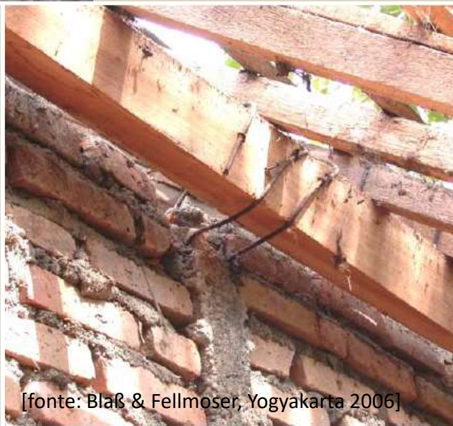
Apertura dei nodi e modifica dello schema statico
