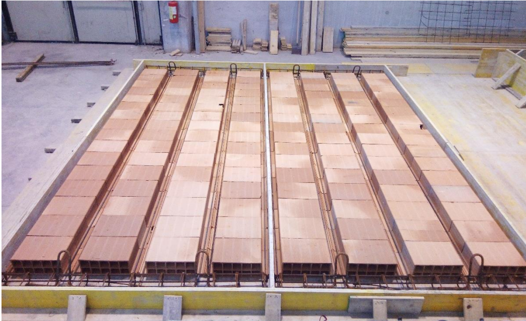
Preparazione del solaio laterocemento
