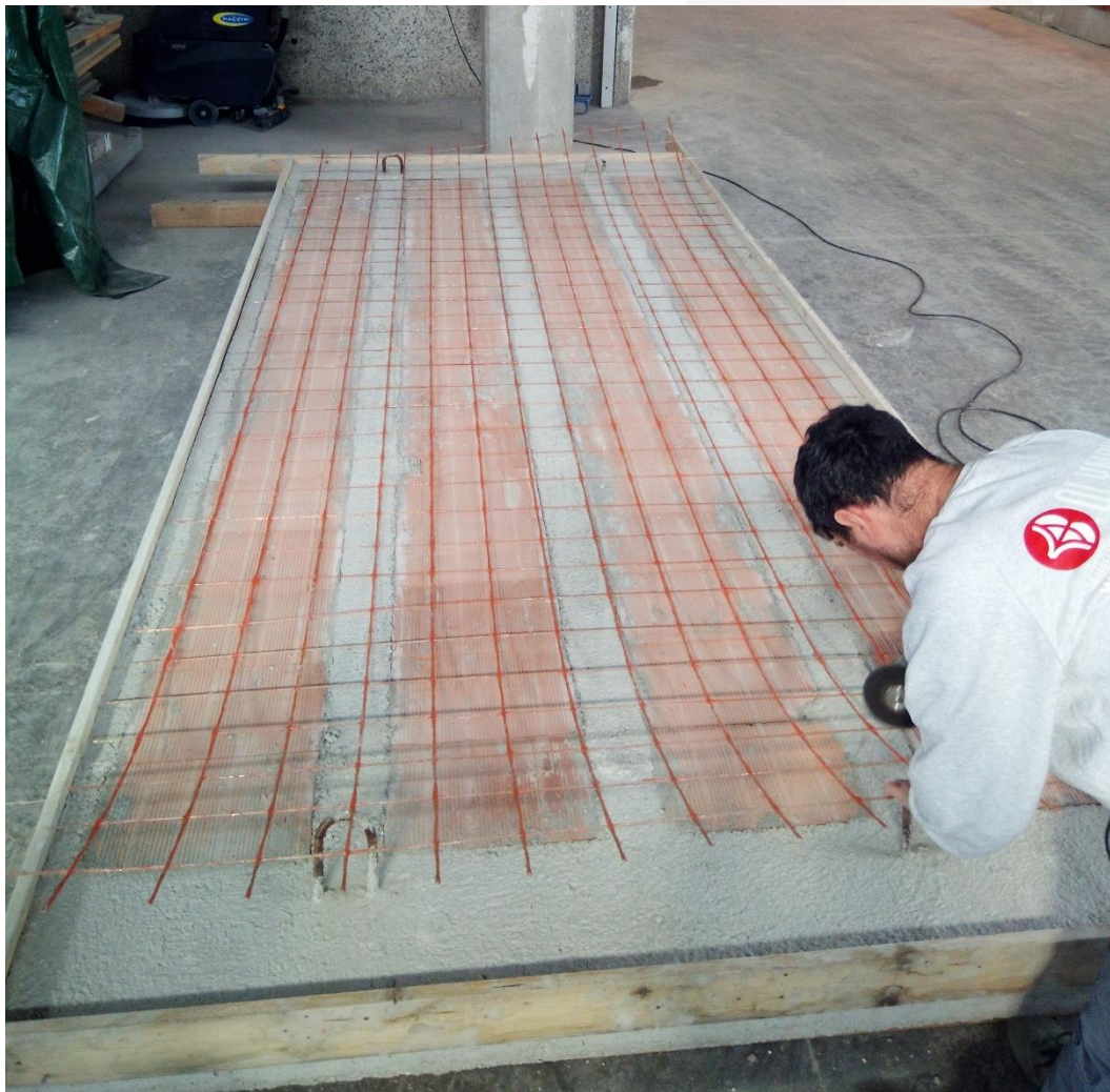
Posa in opera del MASSETTO STRUTTURALE RAPIDO
