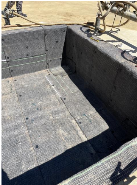
Figura 3: Esempio impermeabilizzazione struttura interrata (fossa ascensore)
