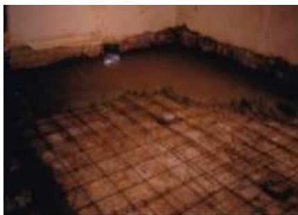
Figura 11: Rilievo in situ volto all'accertamento della presenza di impalcato rigido.
