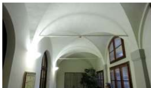
Figura 12: Volte a padiglione nel refettorio (sinistra); volte a crociera nel corridoio della corte (destra).
