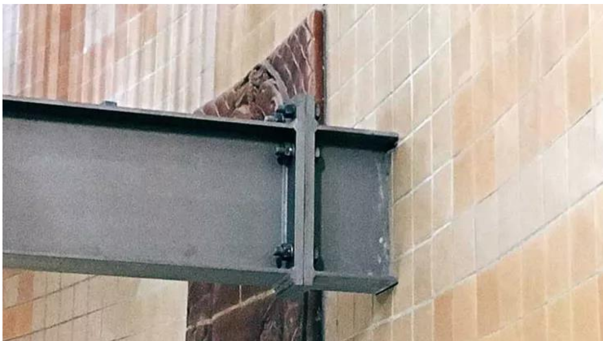
La messa in opera dei supporti in acciaio pieno per la realizzazione della scalinata lungo la parete interna dell'Elbtunnel di St. Pauli. Crediti: fischer
