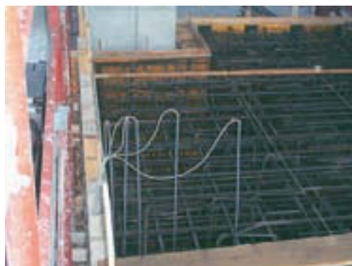
Fig. 2 - Esempio di manufatto massivo (basamento di un mulino da cemento).
