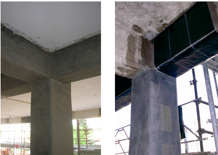
Fig. 7 rinforzi per modificare il meccanismo di rottura
