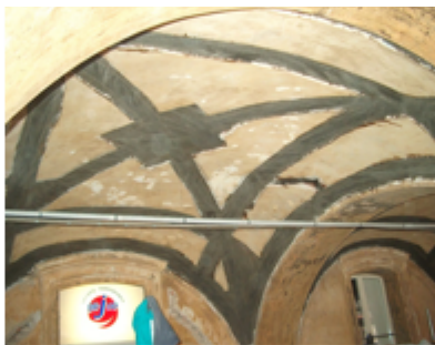
Fig. 5 confinamento della muratura
