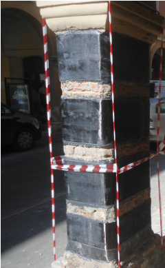
Fig. 5 confinamento della muratura
