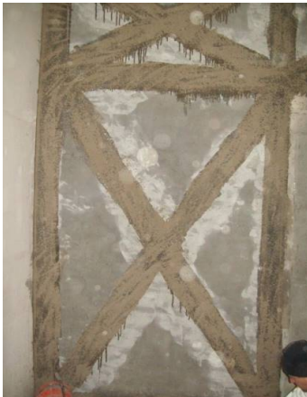
Fig. 4 rinforzi per azioni nel piano (taglio)
