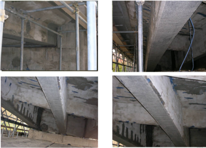
Fig. b: rinforzi per ripristinare la capacità portante strutturale
