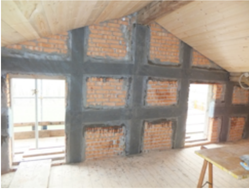
Fig. 2 rinforzo taglio flessione della fascia di piano
